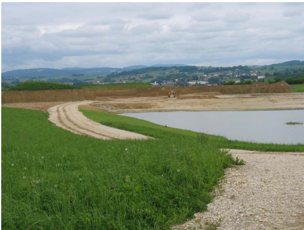
Abb. 3: Eine von mehreren Abbaufächen für die Ziegelproduktion in Bruck-Waasen (Foto: Grossauer, Ingenieurkonsulent für Landschaftsplanung, Gmünd)
