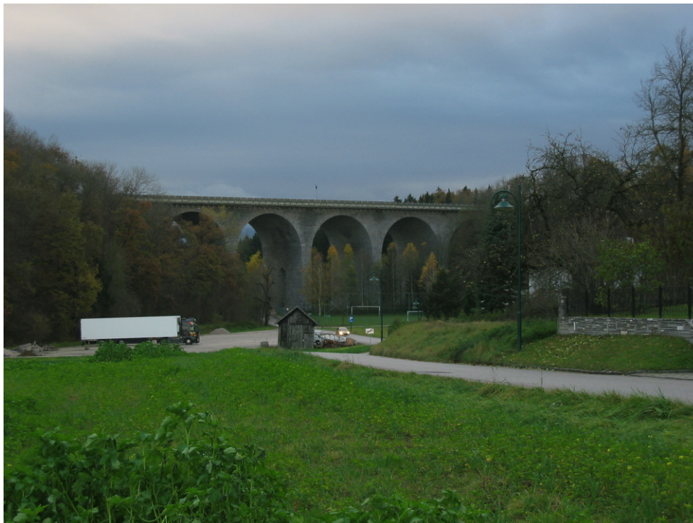
Abb. 2: Autobahnbrücke in Eberstalzell. (Foto: TB Lebensraum)
