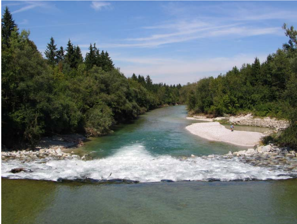
Abb. 4: Die Alm bei Oberhafeld vor dem Zusammenfluss mit der Traun, Sohlschwelle und Schotterinseln, die auch zum Sonnenbaden genutzt werden. (Fotodokumentation Nr. 41807009)
