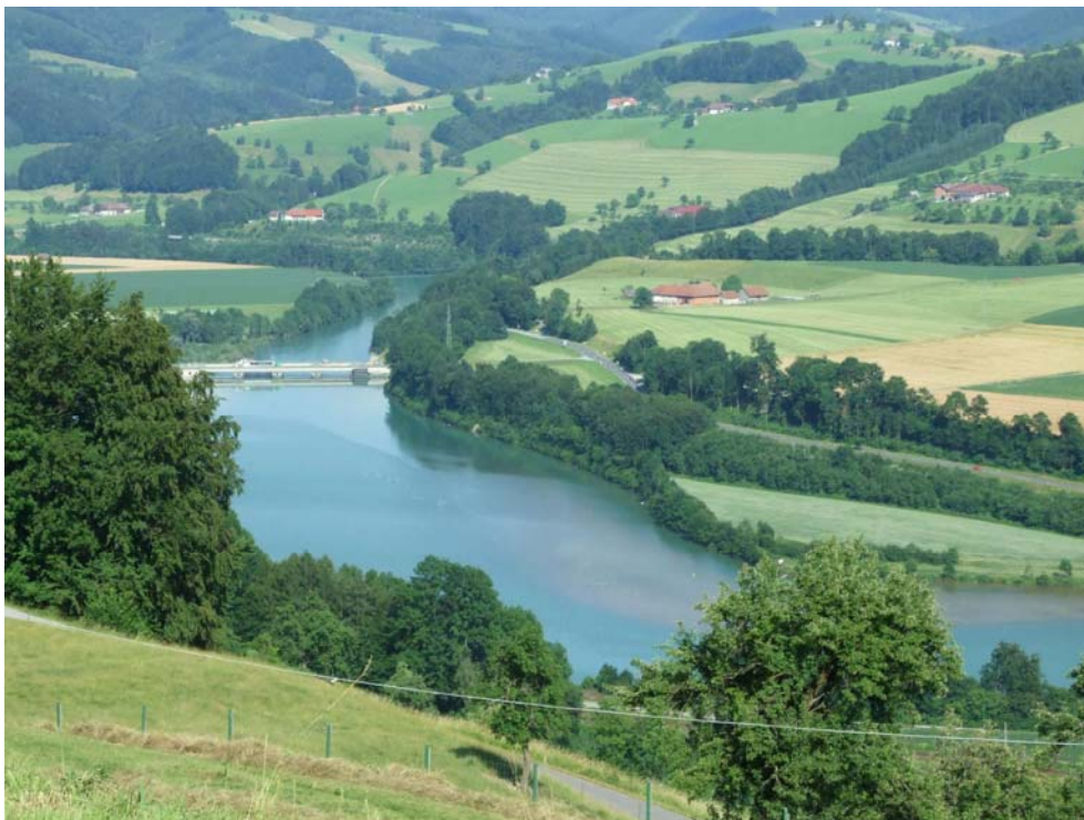
Abb. 14: Blick von oben auf die Enns. Im Hintergrund das Ennskraftwerk zu sehen. (Foto: ARGE DI Raab & DI Grinschgl)
