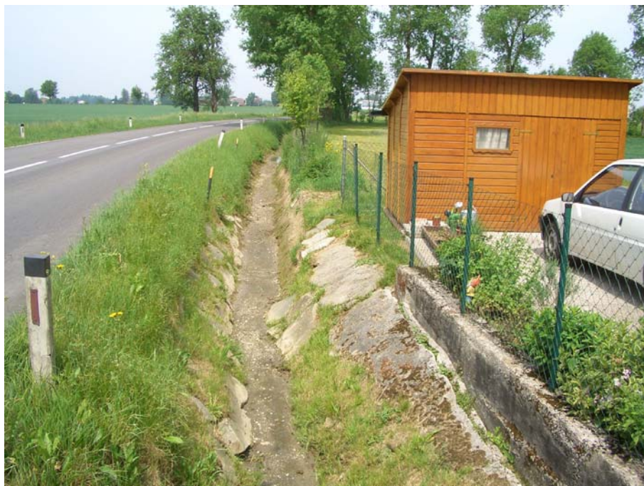
Abb. 10: Schmäler nicht wasserführender Abzuggraben bei Moosham (Foto: Technisches Büro Eisner)
