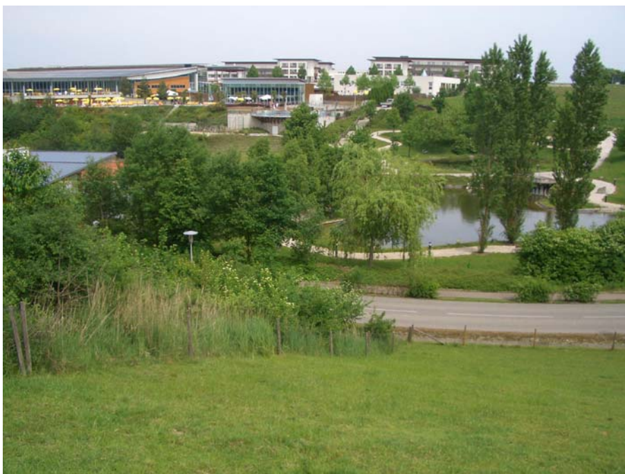
Abb. 14: Gelände der Therme Geinberg (Foto: Technisches Büro Eisner)
