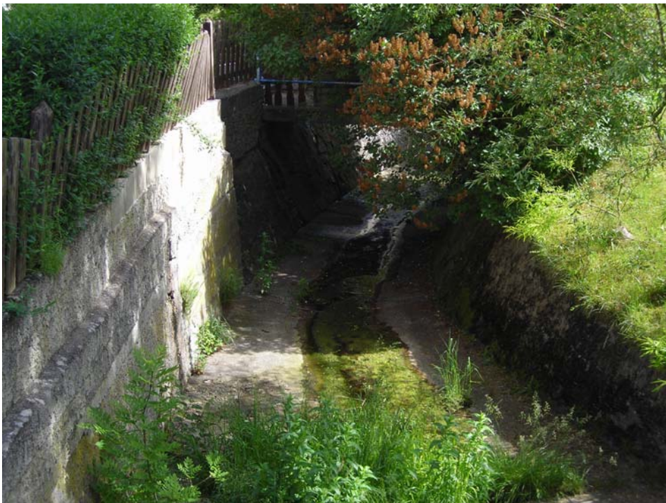
Abb. 22: Kleiner, stark verbauter Bach bei Oberkriebach (Foto: Andrea Lichtenecker)
