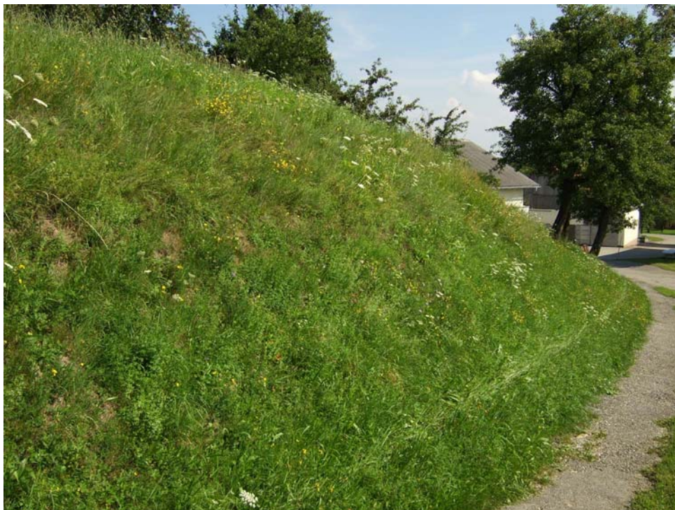
Abb. 2: Trockene Böschung mit Magerwiese bei Kainzing (Foto: FREIRAUMPLANUNG STÖCKL)
