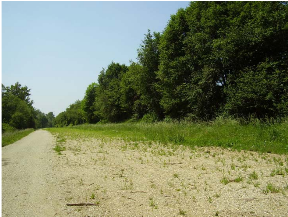
Abb. 11: Dammböschung des Inn bei Ufer (Foto: Technisches Büro Eisner)
