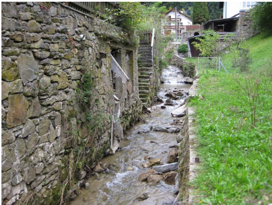
Abb. 6: Großer Haselbach – hart verbauter Abschnitt in Wildberg (Foto: TB Lebensraum)
