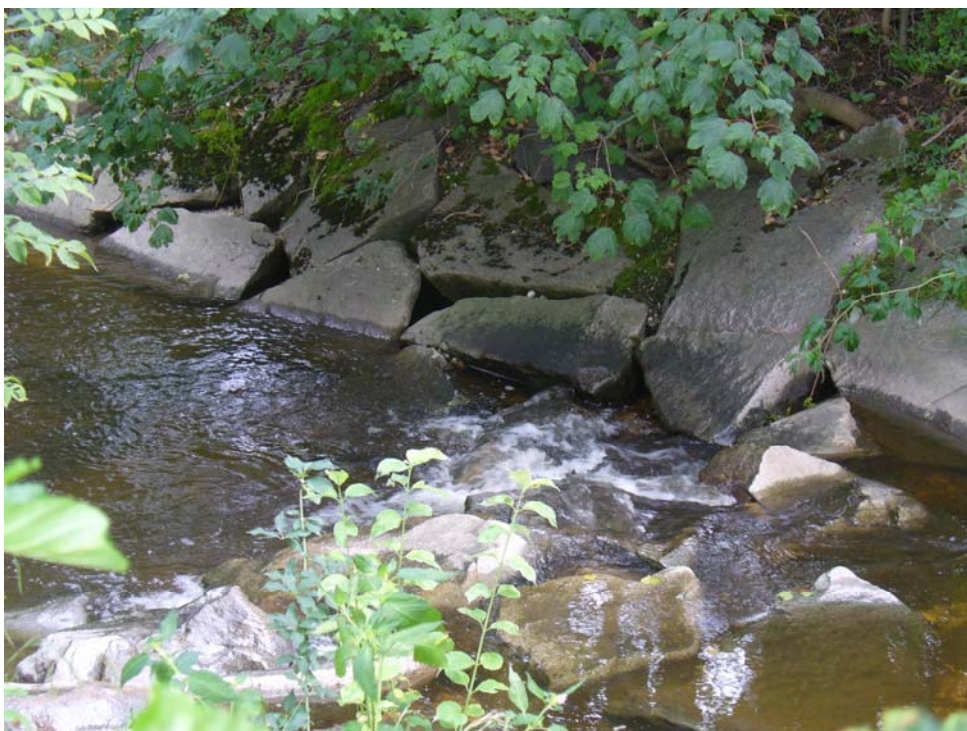
Abb. 4: Waldzeller Ache; Ufersicherung mit Blockschichtung (Foto: Andrea Lichtenecker)
