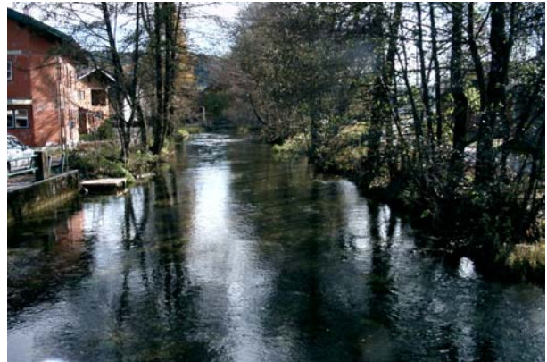
Abb. 8: Der Schwemmbach in Schalchen – lokale Einbauten bzw. Verbauungen sind erkennbar.
