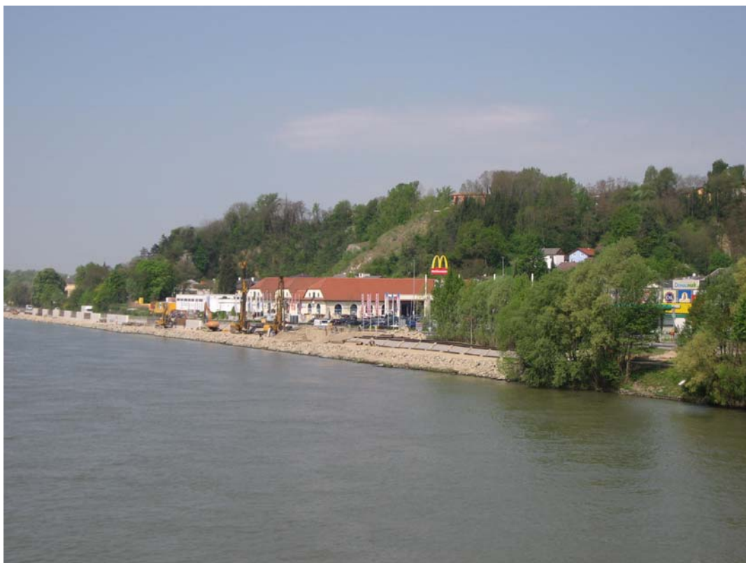
Abb. 9: Baumaßnahmen Hochwasserschutz (Foto: TB Lebensraum)
