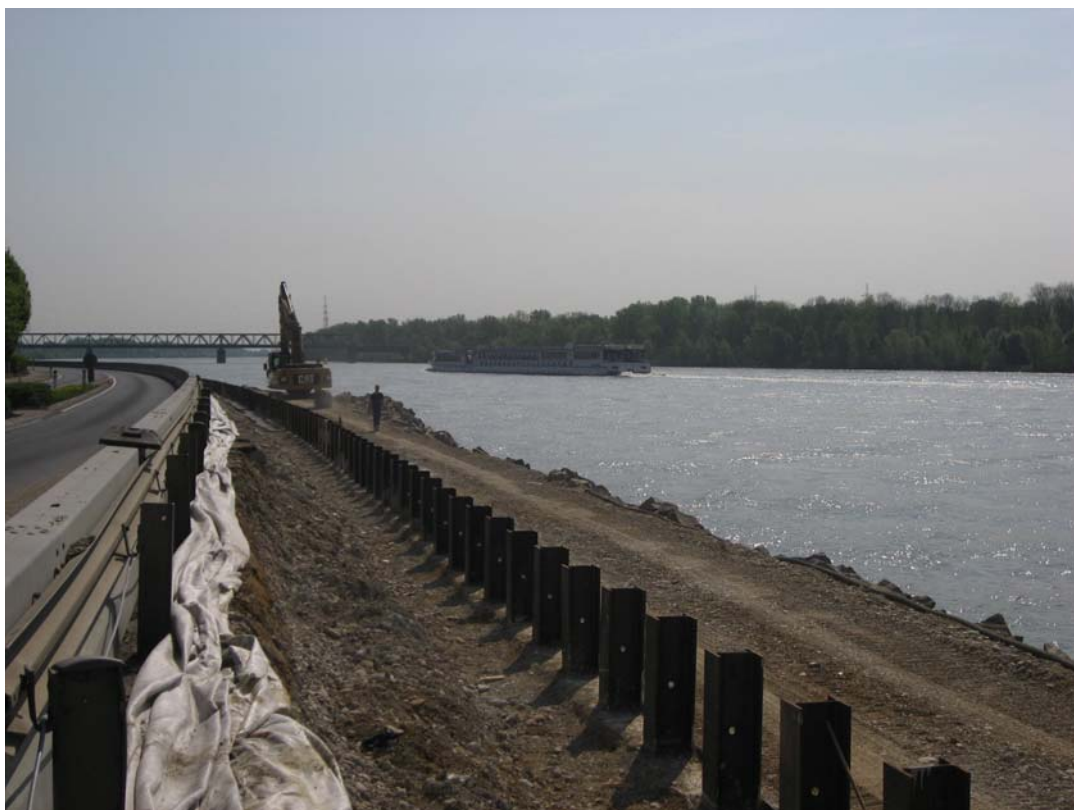
Abb. 8: Baumaßnahmen Hochwasserschutz (Foto: TB Lebensraum)
