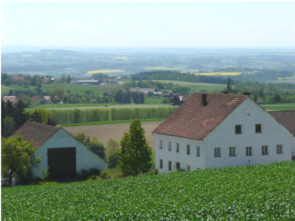
Abb. 9: Gehöft am Südweststrand von Münzkirchen (Brandstetter) (Foto: Kurt Nadler/TB Haug)
