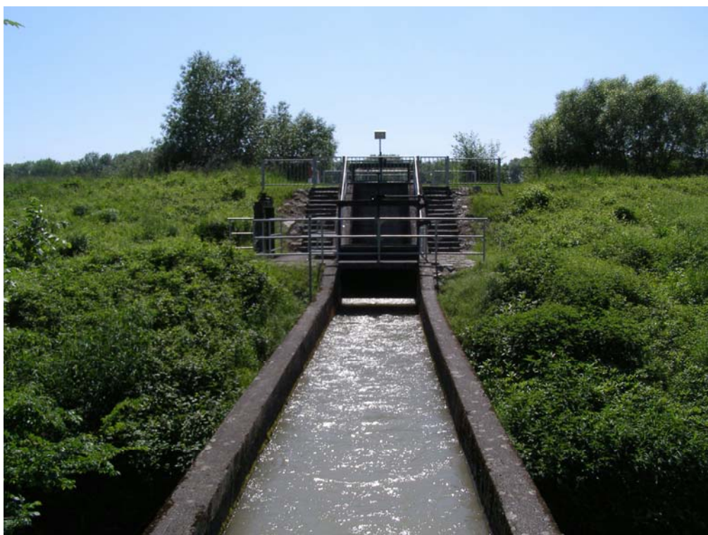
Abb. 10: Einlaufbauwerk bei Au an der Donau (Foto: AVL
