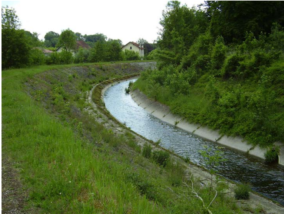
Abb. 1: Hart regulierter Abschnitt des Gurtenbaches (Foto: Technisches Büro Eisner)
