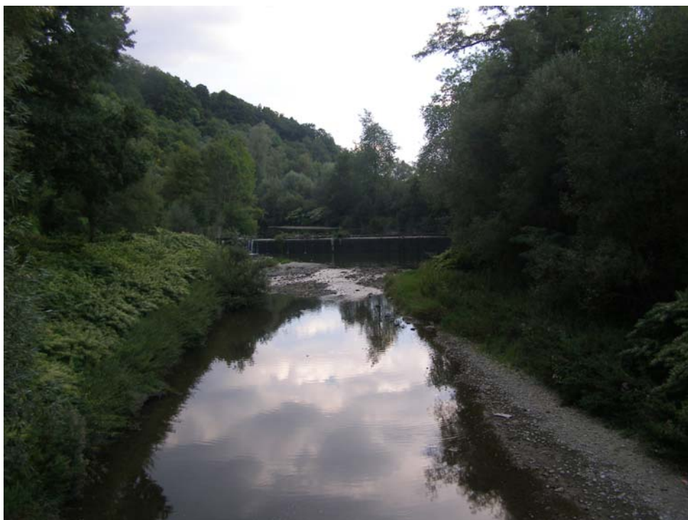
Abb. 8: Antiesen bei Kläranlage (Foto: AVL
