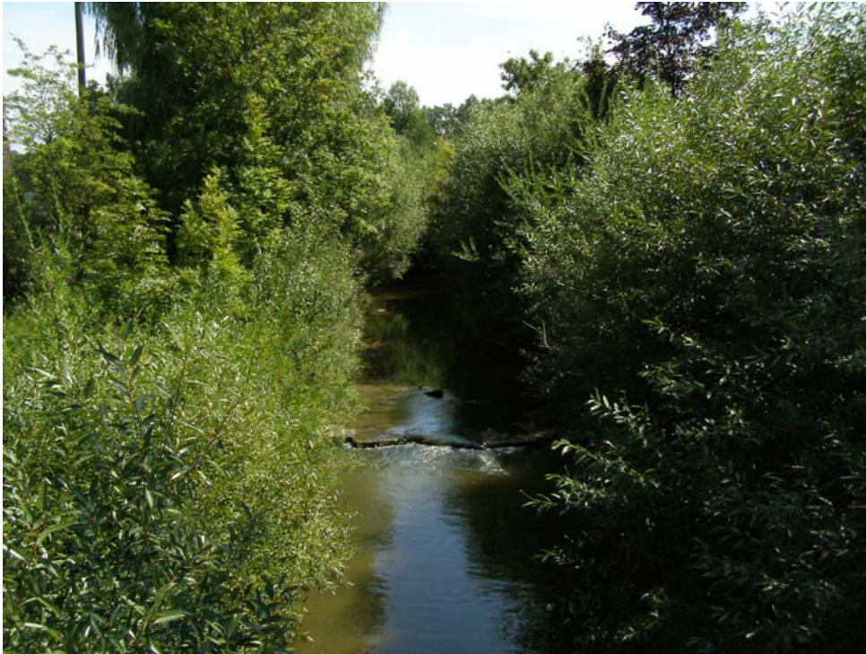
Abb. 1: kleine Sohlschwellen im Aspöckbach (Foto: AVL )
