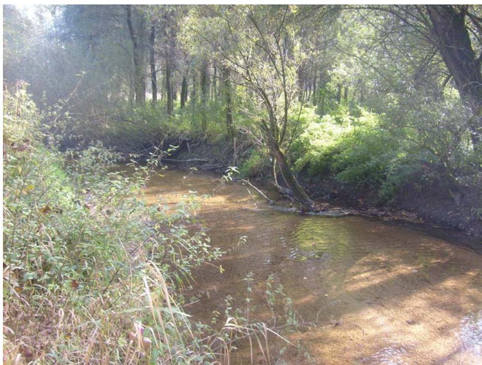
Abb. 20: Uferanbrüche beim Klambach kurz vor der Mündung in die Schwemmnarn (Foto: DI Andreas Raab)
