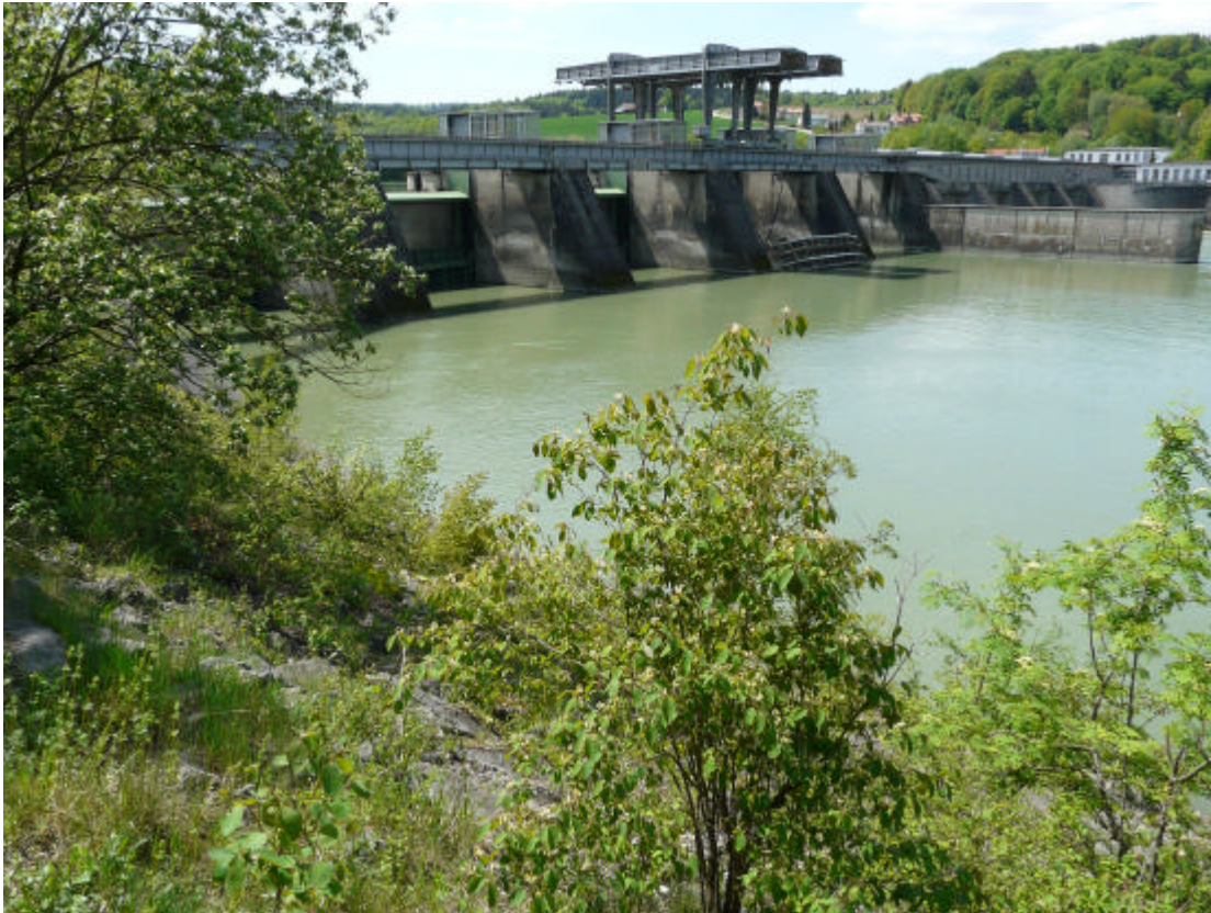
Abb. 7: Innkraftwerk bei Ingling (Foto: Kurt Nadler/TB Haug)
