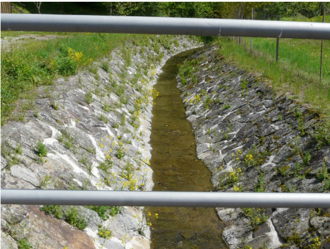
Abb. 6: Regulierter Bachabschnitt zwischen Achleiten und Ingling (Foto: Kurt Nadler/TB Haug)
