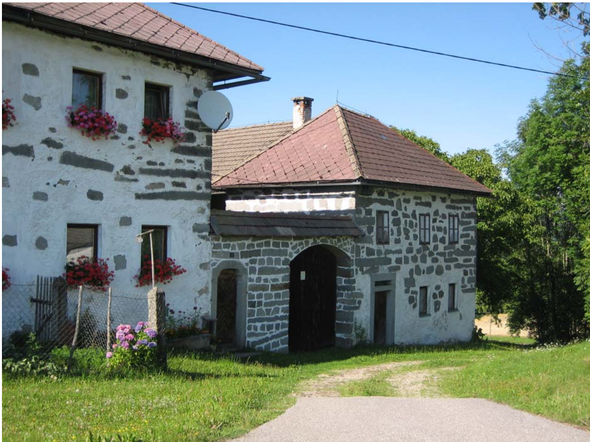
Abb. 3: Alter Dreiseit-Bauernhof mit Blosssteinmauerwerk (Stoabless-Mauerwerk) . (Fotodokumentation Nr. 41339002)
