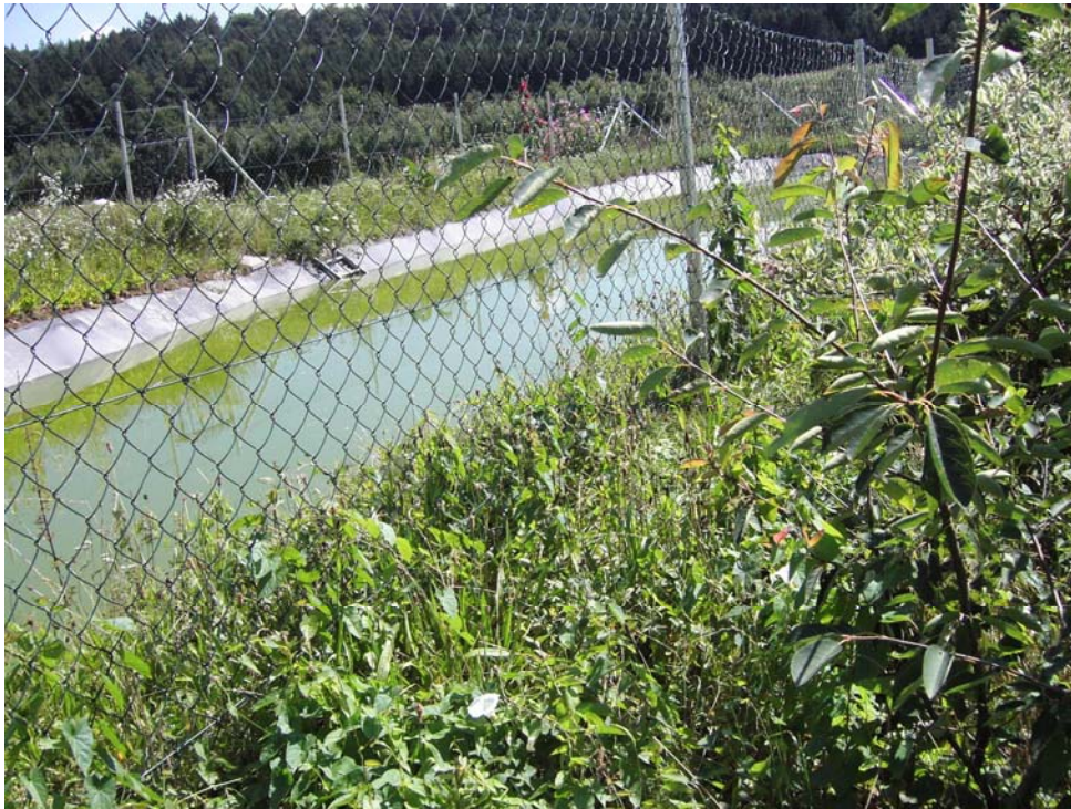
Abb. 11: Folienteich bei Anferding (Kläriteich) (Foto: Mag. Thomas Anzböck)
