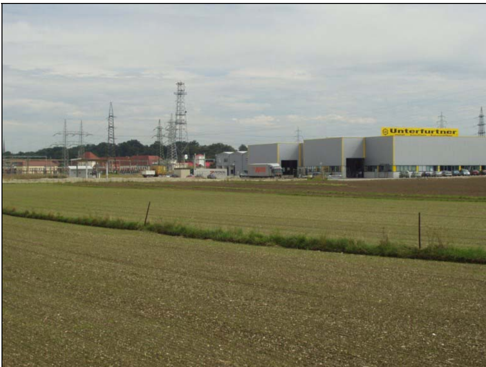
Abb. 16: Gewerbegebiet und VERBUND-Umspannwerk westlich Mooswiesen
