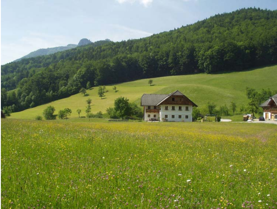
Abb. 15: Renoviertes landwirtschaftliches Gebäude, im Hintergrund Landschaftselemente wie Obstbäume und die Hänge bis zur Großwaldfläche (Foto: REGIOPLAN INGENIEURE Salzburg GmbH)
