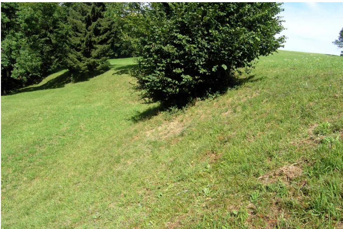
Abb. 22: Überblick Magerböschung mit Einzelgehölzen bei Edbauer (Foto: B. Thurner)
