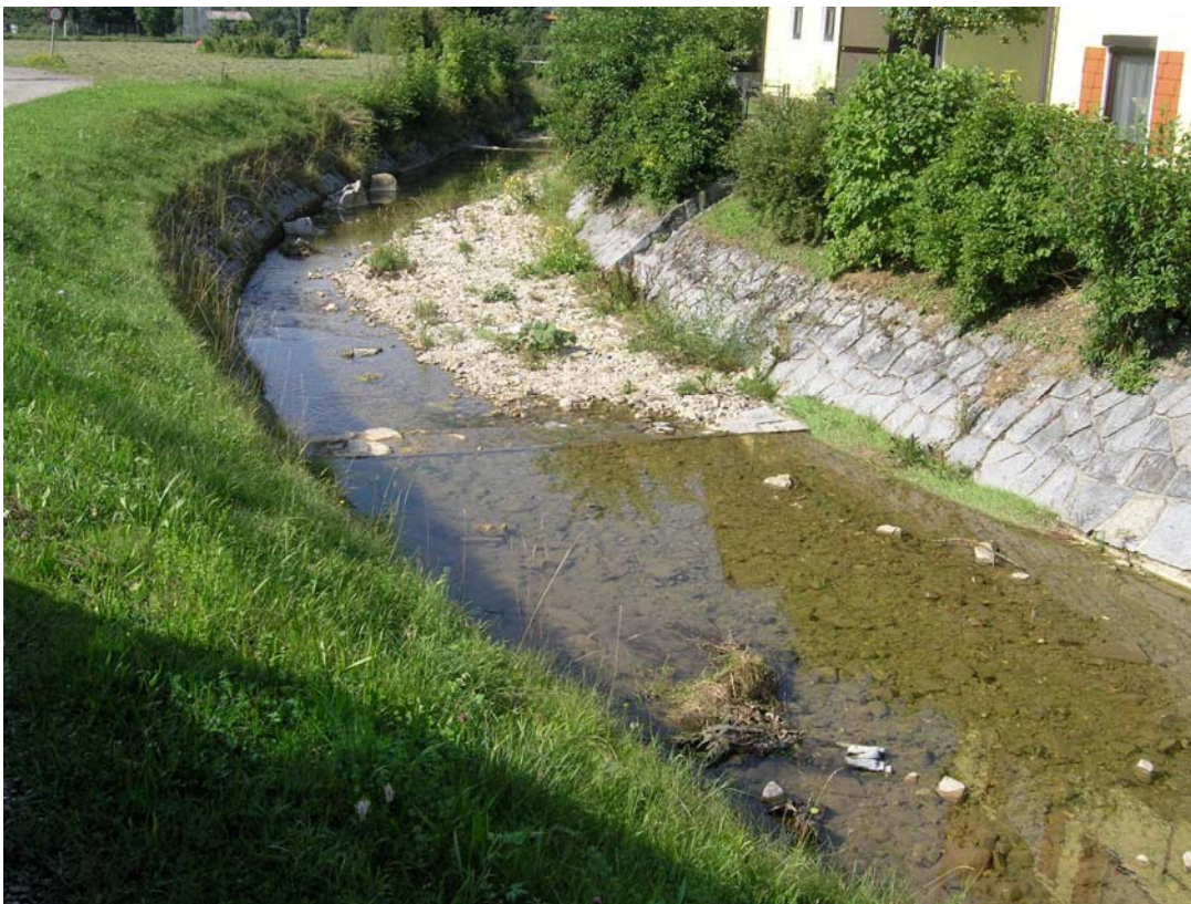
Abb. 14: Aubach in Sagerer, verbaut, mit gemauerten Uferböschungen, Bachgehölz fehlend bzw. mit jungen standortsfremden Gehölzen. (Foto: B. Thurner)
