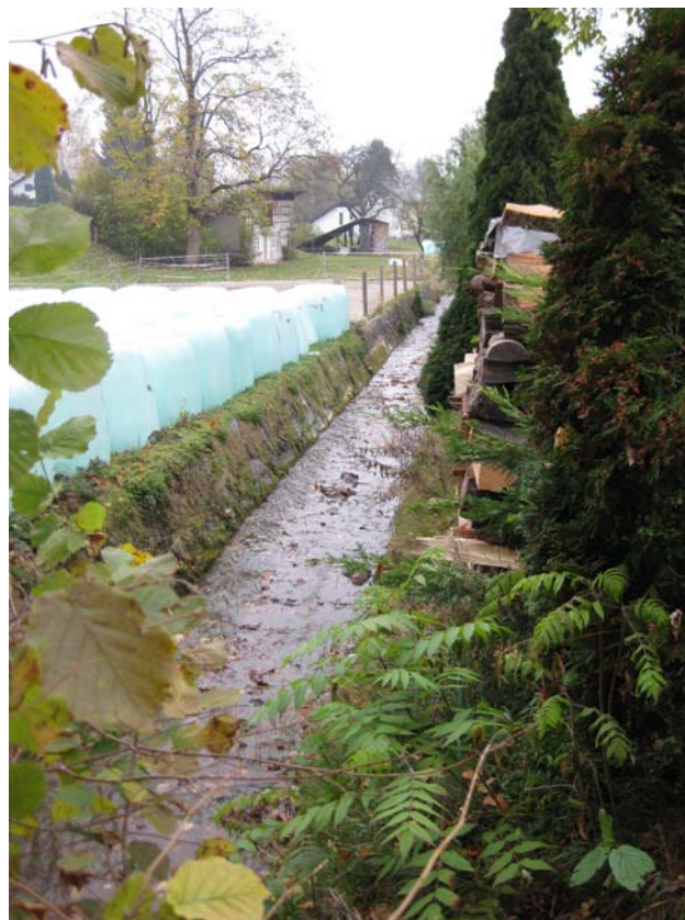
Abb. 6: Hart verbauter Abschnitt des Moosbaches. (Foto: TB Lebensraum)
