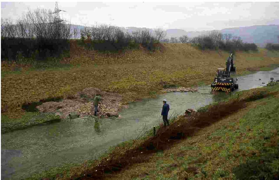
Foto 17006: Renaturierung des Urfahrner Umleitungsgerinnes © Fritz Schwarz
