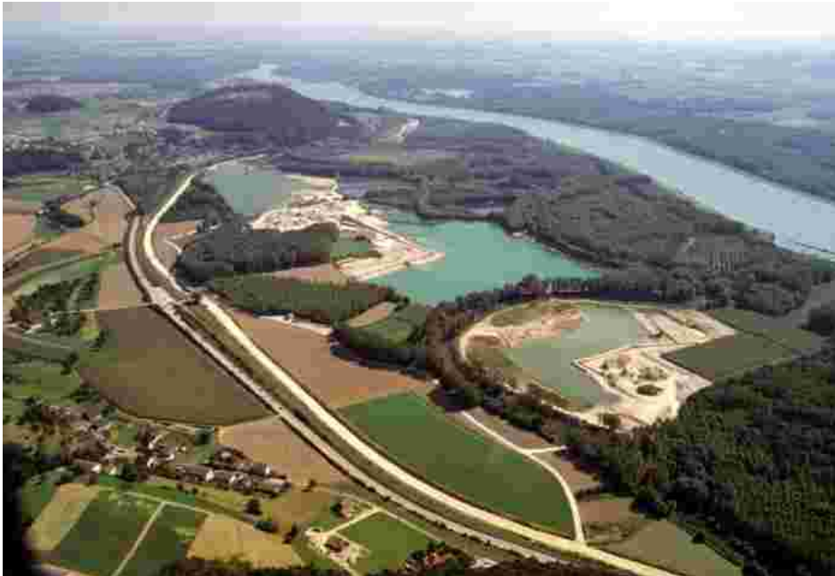
Foto 17001: Großräumiger Schotterabbau in der Ringelau (Gemeinde Steyregg)
