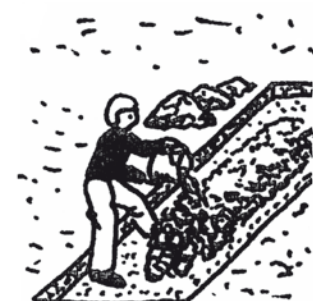
Grasziegel mit Laub überdecken
