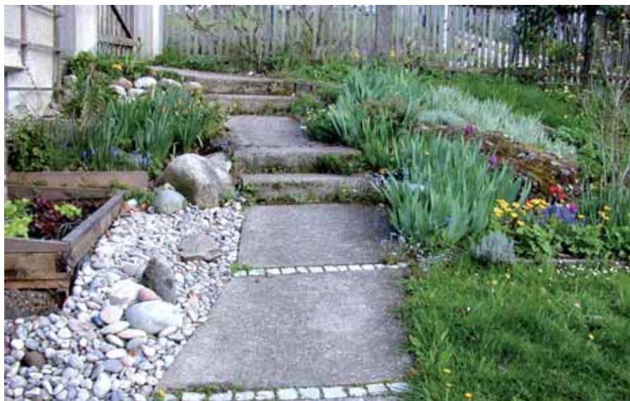
Zugang zum Haus aus Betonplatten mit gewaschener Oberfläche, mit sickerfähigen und begrünten Pflasterfugen gegliedert.
