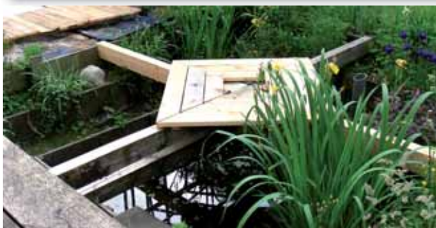
Stufenförmig abgetreppter Regenwasserteich. Der Wasserstand schwankt zwischen 20 cm in Trockenzeiten und 90 cm nach starken Niederschlägen.
