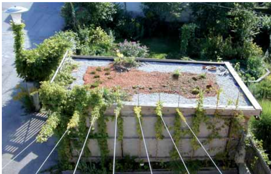
Garagendach mit Extensivbegrünung: Auf einer wenige Zentimeter dicken Substratschicht wachsen trockenheitsliebende Moose und Kräuter.
