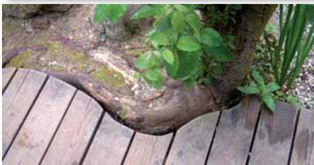
Detail am Rande: Die Terrasse wurde der Wurzel eines bestehenden Baumes angepasst.
