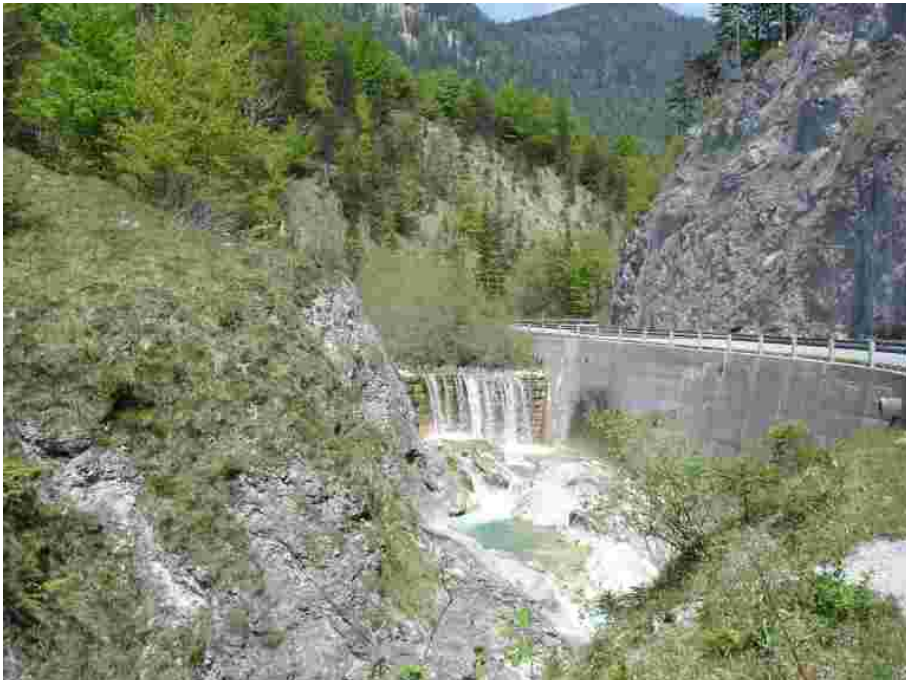
Foto 24004: Offenseebach stark verbaut
