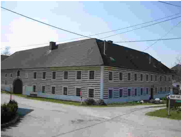
Foto 33003: Vierkanter mit Streifenmauerputz
