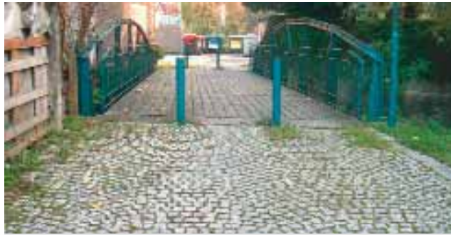
Pflaster mit sandgefüllten Fugen lassen Regenwasser versickern und begrünen sich entsprechend ihrer Nutzung.
