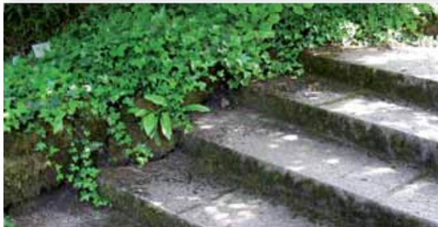
Stiegen aus Blockstufen werden an ihren Rändern von Moosen und Mauerritzenvegetation begrünt.
