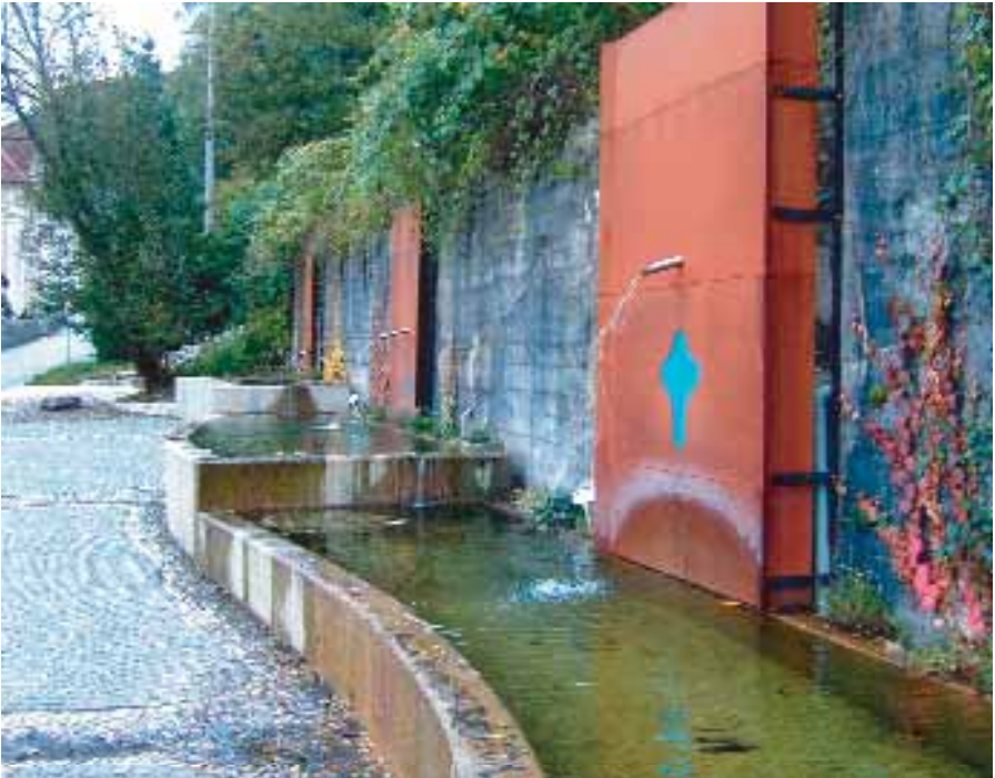
Brunnenanlage am Kirchenplatz, gespeist aus dem Überwasser der Trinkwasserversorgung.
