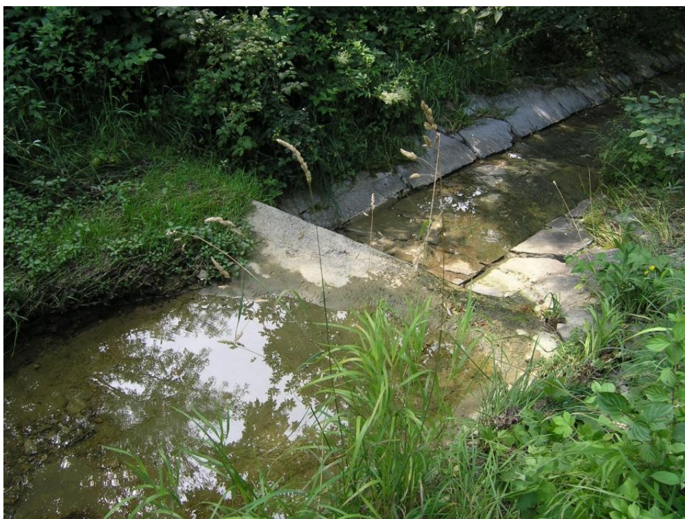
Abbildung 38: Hart verbauter Bachabschnitt beim Durchlass unter der Westautobahn A1.
