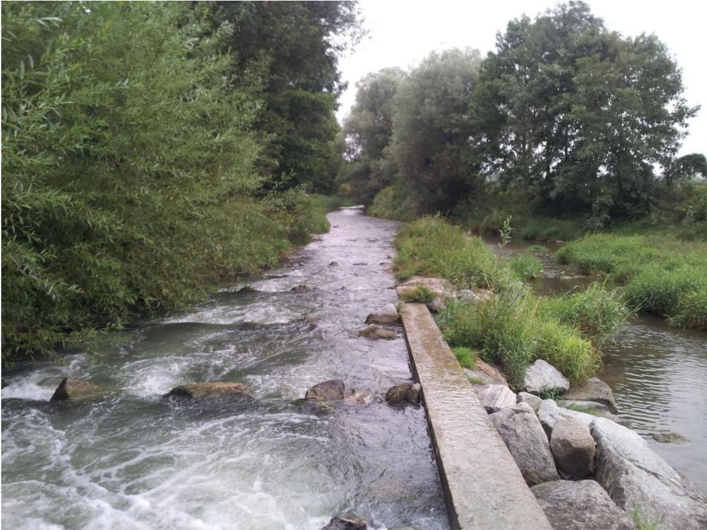
Abbildung 49: Unterlauf der Krems im Auegebiet der Traun in der Gemeinde Ansfelden. In der Mitte der Strecke liegt ein kleines Wehr, das ca. 50 Prozent des Wassers in einen Mühlbach ableitet (Fotonr. 201110410020729B).
