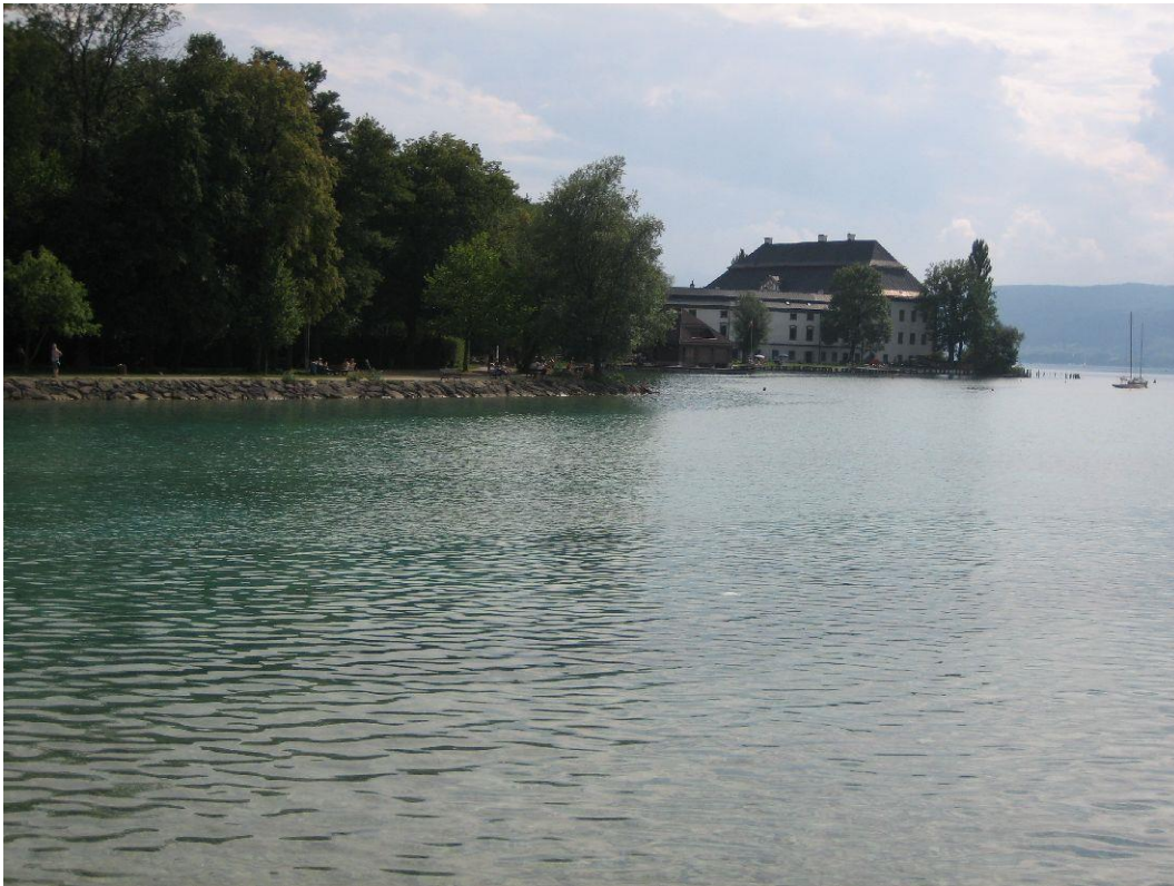
Abbildung 2: Flachwasserzone am nördlichen Ende des Attersees mit harter Uferverbauung und im Hintergrund Schloss Kammer (Fotonr. 200501417370366a).
