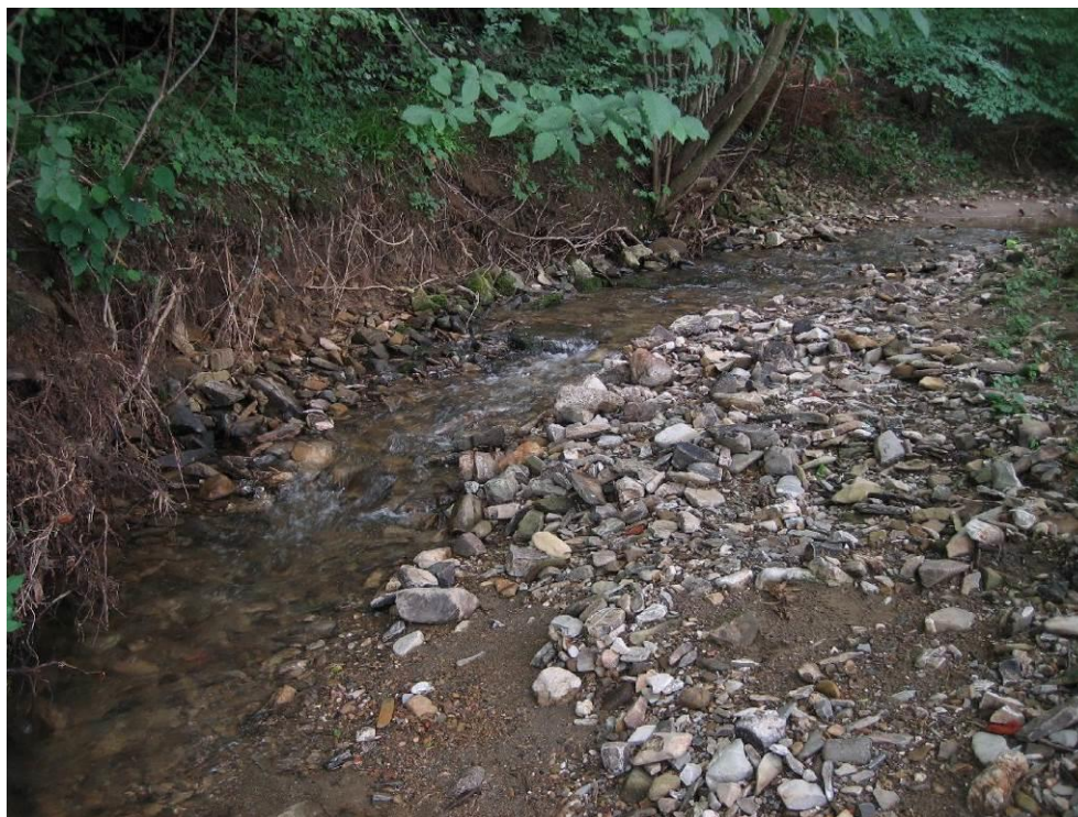
Abbildung 7: Sickingbach mit unterspültem Prallufer (Fotonr. 200501417370139b).
