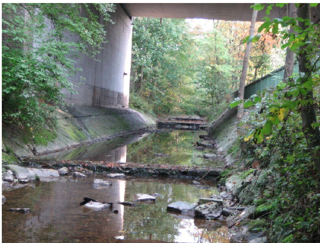
Abbildung 40: Hart verbauter Bachabschnitt des Steinbachs beim Durchlass unter der Westautobahn A1 (Foto: E. Nußbaumer)
