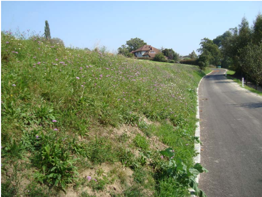
Abbildung 35: Magerwiesenböschung westlich von Wieshof, die vom Ausbau des angrenzenden Güterweges beeinträchtigt wurde (offene Bodenstellen) (Fotonr.: 200902405100183).
