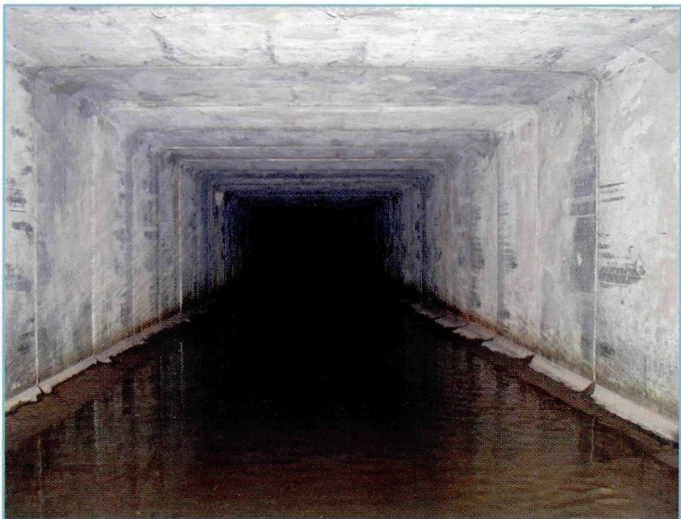
Abb. 7.2: In Ried in der Riedmark fließt der Rieder Bach in einem Kastendurchlass
