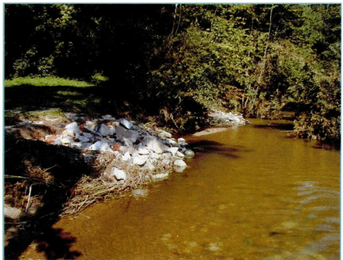
Abb. 6.1: “Ufersicherung” aus Bauschutt an der Kleinen Gusen oberhalb Unterweikersdorf.
