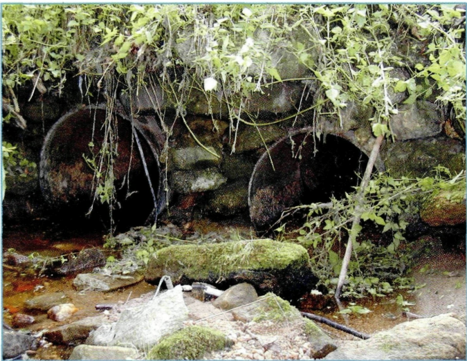
Abb. 7.5: Dieser Rohrdurchlass im Lehrreitbach ist durch eine Brücke zu ersetzen
