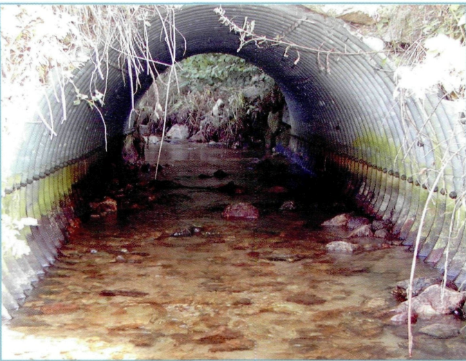
Abb. 5.38: Der ungehindert passierbare Rohrdurchlass Nr. 5/6-1.
