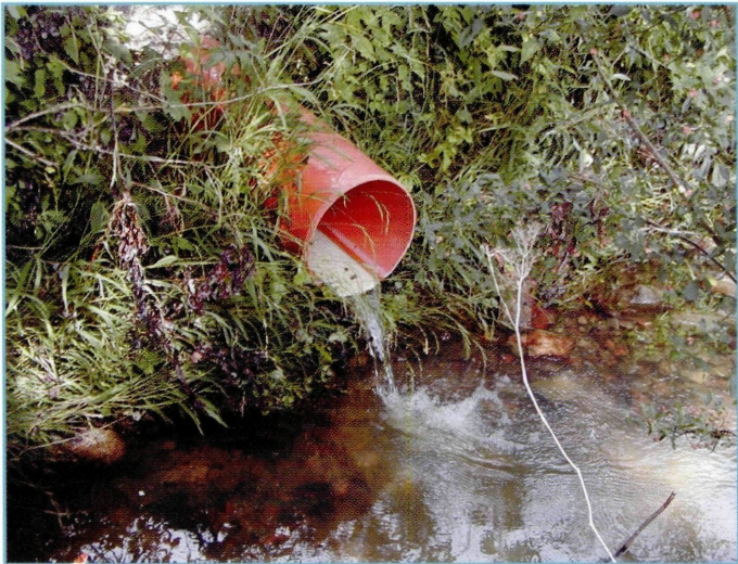
Abb. 5.25: Die Mündung eines verrohrten Wiesengraben in Katsdorf
