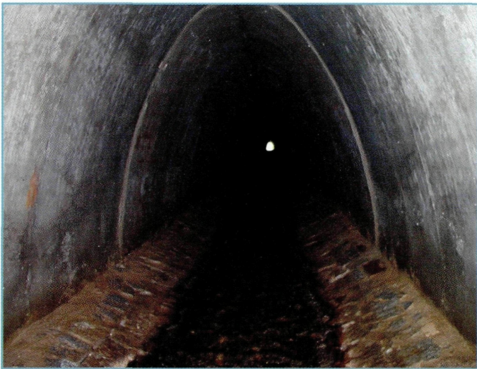
Abb. 7.4: Die Sohle des Durchlasses wird durch den Einbau von Strukturen besser passierbar
