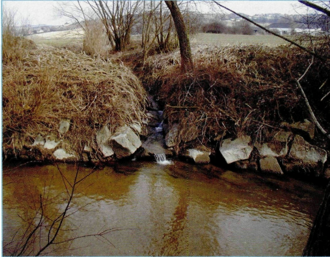
Abb. 5.15: Abtrennung der Mündung eines Zubringers durch Blockwurfsicherung im Hauptfluss
