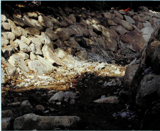
Abb. 5.35: Ökologisch nachteilige Neu-Verbauung des Visnitzbaches im Bereich der Ortschaft Stöcklgraben in Hagenberg im Mühlkreis nach der Hochwasserkatastrophe
