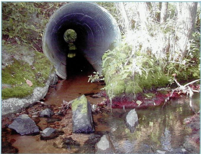
Abb. 5.34: Der passierbare Rohrdurchlass im Mündungsbereich des Reitlinger Baches
