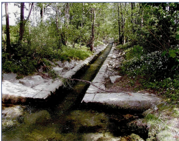
Abb. 69: Bei Kirchdorf ist die Krems zur Gänze in einem Betonbett gefasst.
