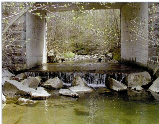
Abb. 8: Dieses Querbauwerk verfügt über eine ganze Reihe konstruktiver Merkmale (siehe Text), die die Passierbarkeit verhindern.
