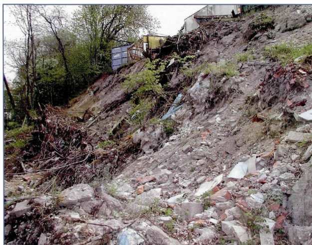
Abb. 16: Diese etwa 30 m hohe Böschung flussaufwärts von Kremsmünster besteht aus Schutt, Müll und Problemstoffen.
