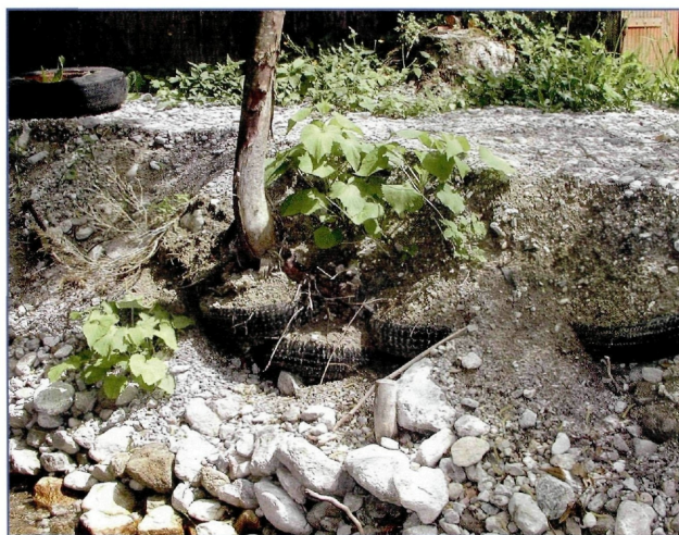
Abb. 15: Eine aus gewässerökologischer Sicht unvertretbare Ufersicherung mittels Altreifen im Krems- Oberlauf.
