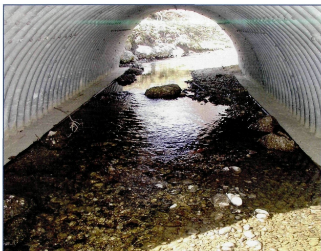
Abb. 35: Querbauwerk Nr. 4-6 im Dambach, ein sohloffener Rohrdurchlass.
