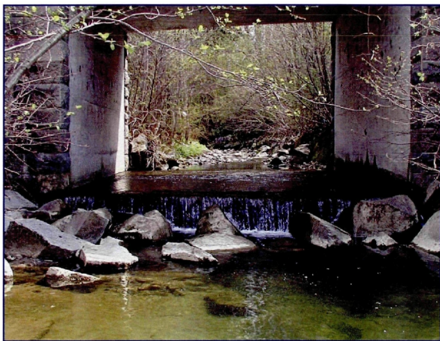
Abb. 7: Dieses Querbauwerk verfügt über eine ganze Reihe konstruktiver Merkmale, die die Passierbarkeit verhindern (Foto: Nußbach, Krems-Einzugsgebiet).
