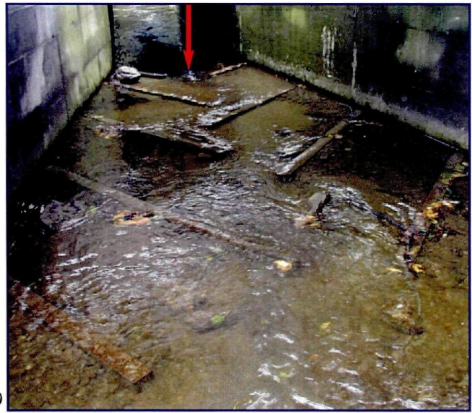
Abb. 15 a und b: Im ÖBB-Durchlass Nr. 8-4 wurde mittels Holzbalken eine Niederwasserrinne hergestellt.
