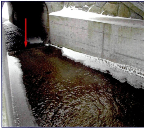
Abb. 15 a und b: Im ÖBB-Durchlass Nr. 8-4 wurde mittels Holzbalken eine Niederwasserrinne hergestellt.
