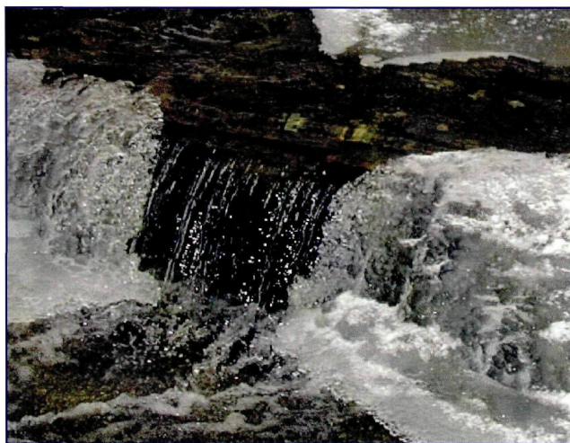
Abb. 6: Ein abgelöster Wasserstrahl ist für die aquatische Fauna nicht durchwanderbar (Detail des Querbauwerkes Nr. 8-5 im Frühjahr 2002).
