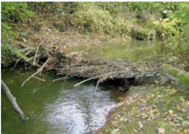
Abb. 30: Auch kleine Querbauwerke, wie dieses im Planbach (Innbach-Einzugsgebiet), können die Längsdurchgängigkeit in Fließgewässern beeinträchtigen. Durch die Ansammlung von Totholz besteht kein kompakter Wasserkörper mehr, wodurch keine Passierbarkeit für Fische gegeben ist. Makrozoobenthosorganismen können das Hindernis hingegen weitgehend ungestört passieren.
