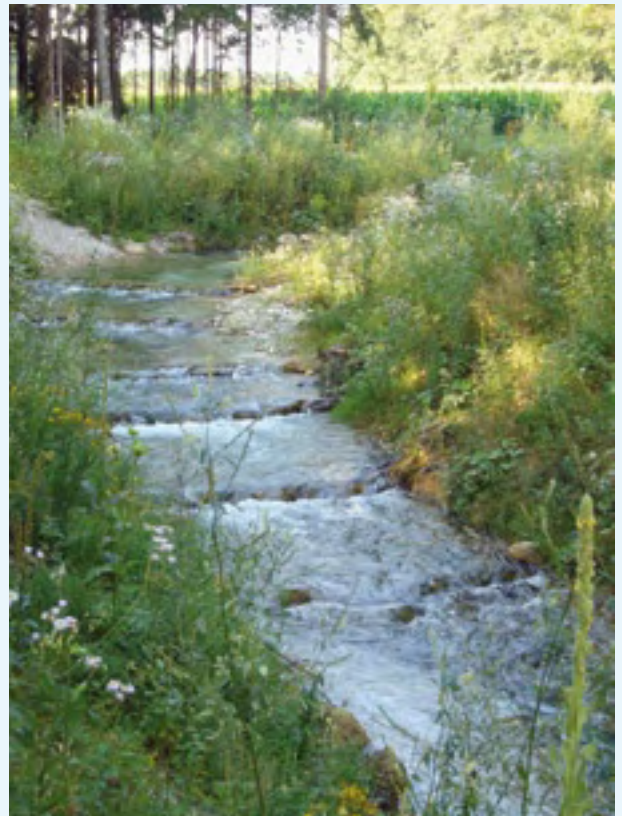
Abb. 44: Das naturnahe Umgehungsgerinne wurde in Form aufeinander folgender Becken in die Landschaft eingepasst.
