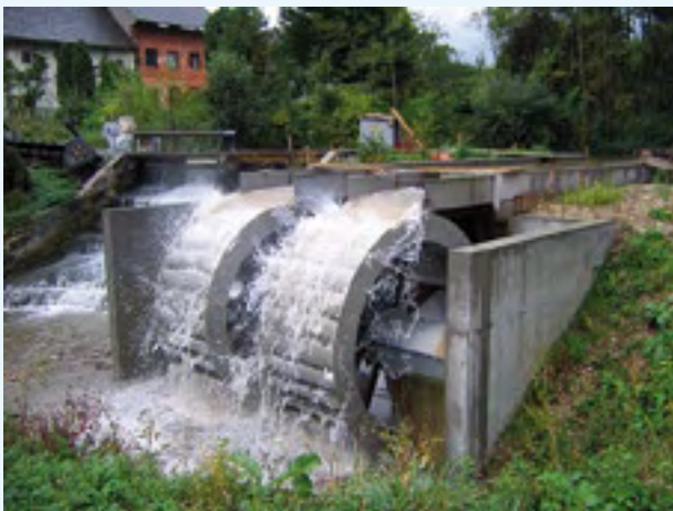
Abb. 62: Die beiden Wasserräder wurden neben dem alten Wehr installiert, sodass bei Hochwasserabfluss die Wehrklappen geöffnet werden können und keine Beschädigung des Standortes zu befürchten ist (Foto: M. Köpl).
