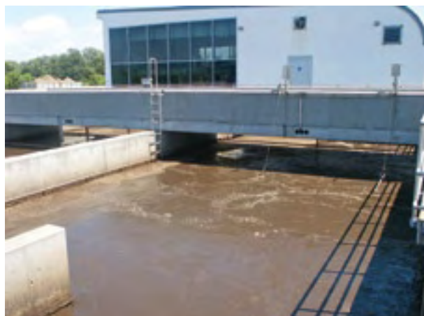
Abb. 20: Die Bakterienbiomasse wird in den Belebtschlammbecken der Abwasserreinigungsanlagen künstlich hoch gehalten (Foto: C. Giefing).
