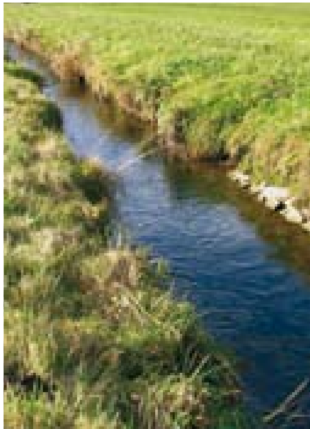
Abb. 95: Nahezu über den gesamten Mittellauf ist der Kretschbach in einem Trapezprofil aus Blocksteinen geführt
