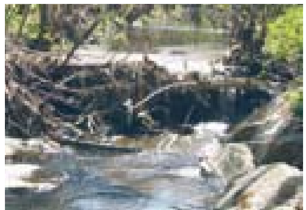
Abb. 12: Querbauwerke, die von einer Vielzahl kleiner Wasserkörper durchströmt sind (Albertsedterbach), sind für Fische unpassierbar
