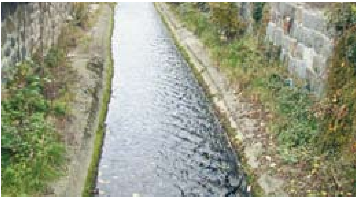
Abb. 18: Die Breitsach wird durch das Ortszentrum von Ried in einem Betonbett geführt
