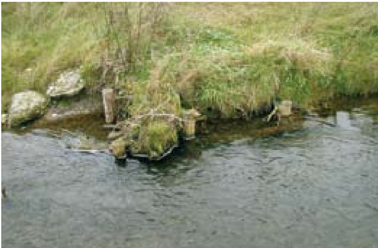
Abb. 98: Ingenieurbiologische Sicherungen ermöglichen eine naturnahe Wasser-Umland-Vernetzung
