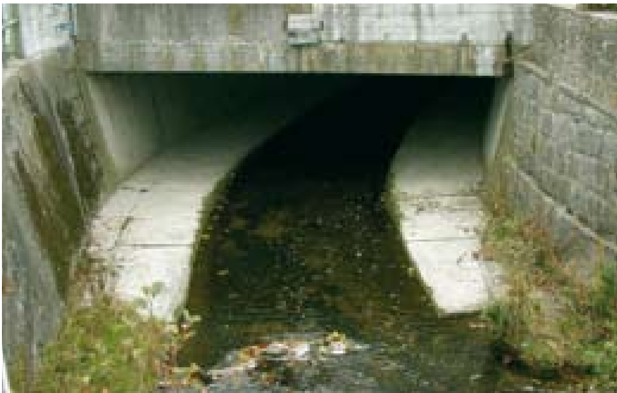
Abb. 100: Im Stadtzentrum von Ried ist die Breitsach teils unter Verkehrsflächen hindurch massiv verbaut
