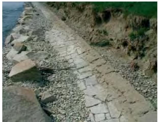
Abb. 3 und Abb. 4: Freigelegte Blockwurfsicherung an der Krems nach dem Hochwasser im August 2002
