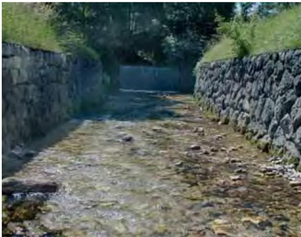
Abb. 44: Das Profil 1 im regulierten Abschnitt 1 der Krems bei Micheldorf (siehe auch Abb. 46) als Beispiel für eine Kanalisierung mit Sohlpflasterung und Ufermauer
