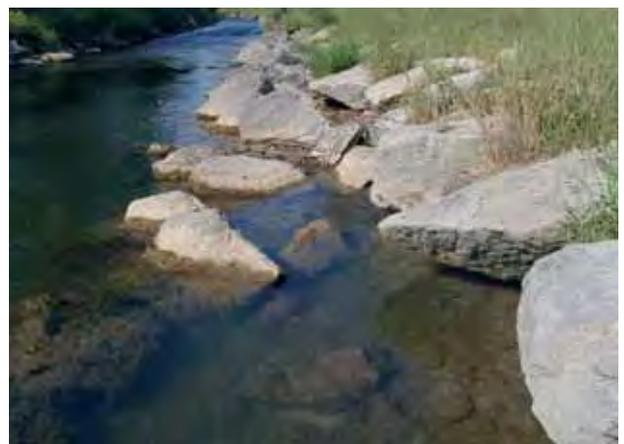
**Abb. 84:** Die lose, aus großen Blöcken bestehende Ufersicherung im regulierten Abschnitt 5 der Krens bei Rohr im Kremstal hat einen hohen Variationskoeffizienten der Maximaltiefen zur Folge
