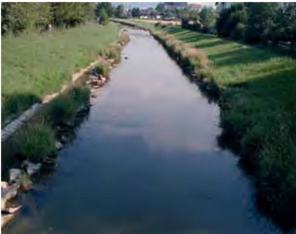
Abb. 48: Teil des regulierten Abschnittes 4 der Krens bei Wartberg als Beispiel für eine Ufersicherung mit Blockwurf (siehe auch Abb. 51)
