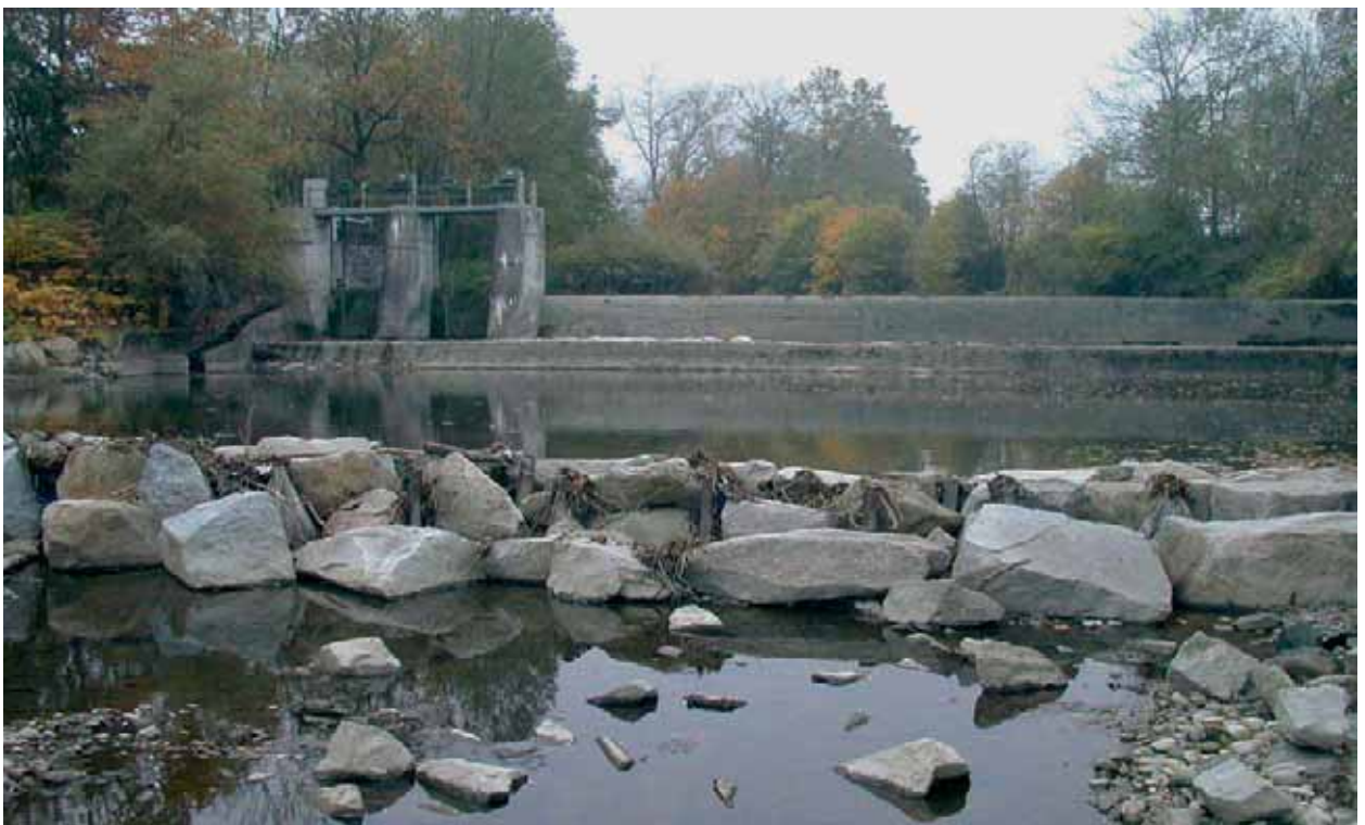
Abb. 17: Die Wehranlage des Kraftwerks Hübinger (Schmerlbäck) stellt eine unüberwindbare Hürde für die aquatische Fauna dar
