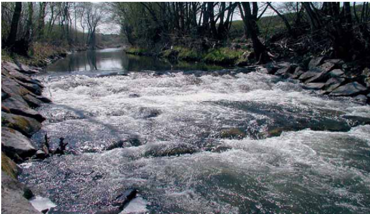
Abb. 24: Die Sohlrampe in der Probestrecke 1-11 ist für Fische nur eingeschränkt passierbar
