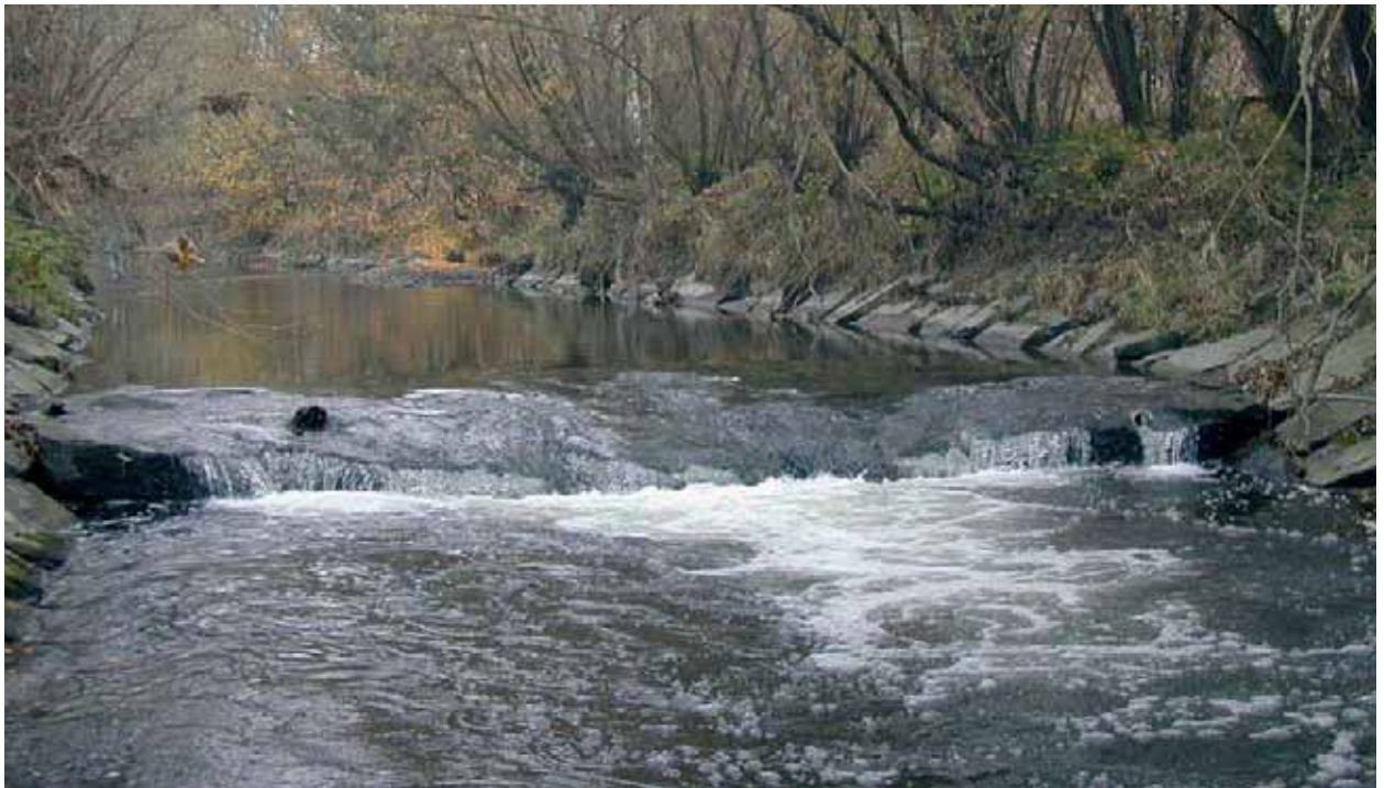
Abb. 40: Sohlschwelle im regulierten Unterlauf des Rieder Bach
