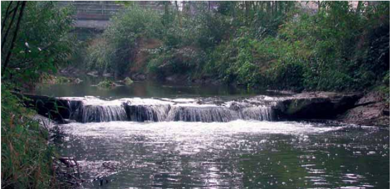
Abb. 77: Die unpassierbare Sohlstufe im Mündungsbereich der Osternach verhindert Einwanderungen von Fischen aus der Antiesen
