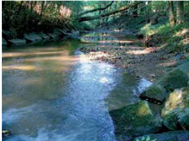
Abb. 37: Der Senftenbach wurde im Unterlauf reguliert und beidufrig mit Blockwurf gesichert
