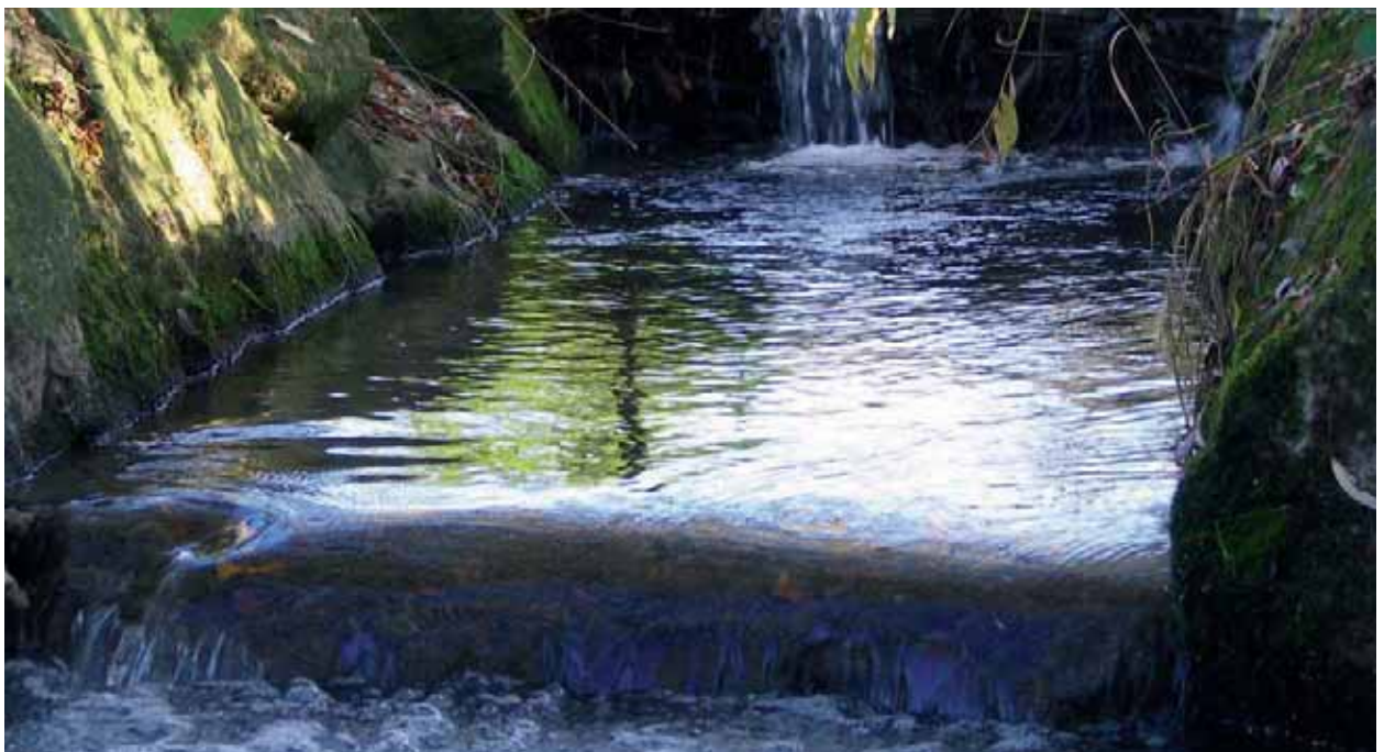
Abb. 64: Auch im Senftenbach behindern etliche Querbauwerke die freie Durchwanderbarkeit für die Fischfauna
