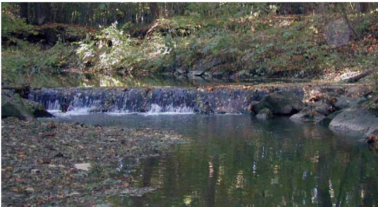
Abb. 63: Durch zahlreiche Querbauwerke kommt es zur Zerstückelung des Senftenbaches
