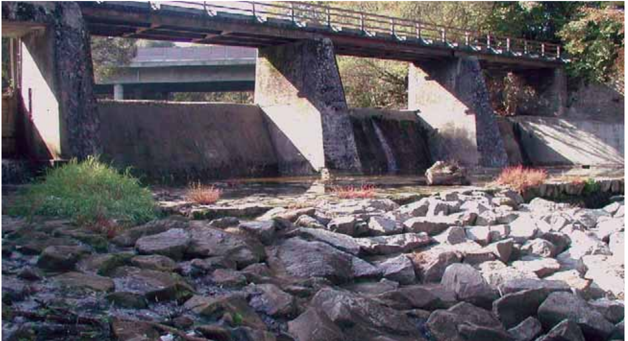
Abb. 86: Die Unterbrechung des Gewässerkontinuums, wie hier beispielsweise bei der Schätzmühle, stellt den invasivsten morphologischen Eingriff des Menschen in das Gewässerökosystem dar
