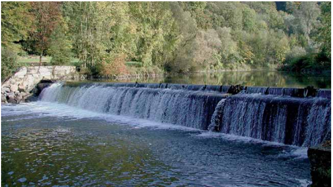
Abb. 20: Das Steilwehr in Au dient der Ausleitung von Wasser aus der Antiesen
