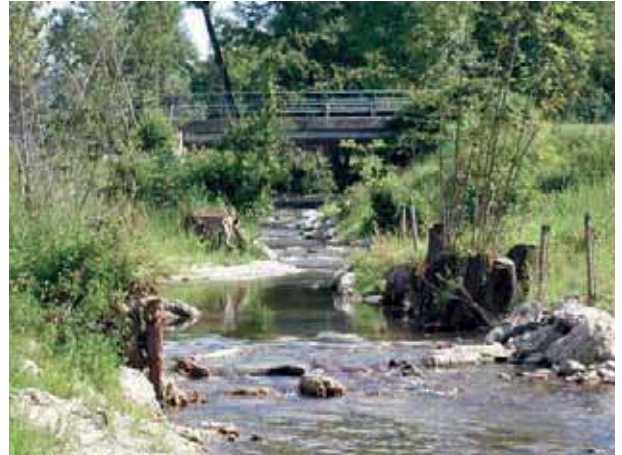
Abb. 68: Im Ortszentrum von Eberschwang wurde die Antiesen saniert und naturnah gestaltet
