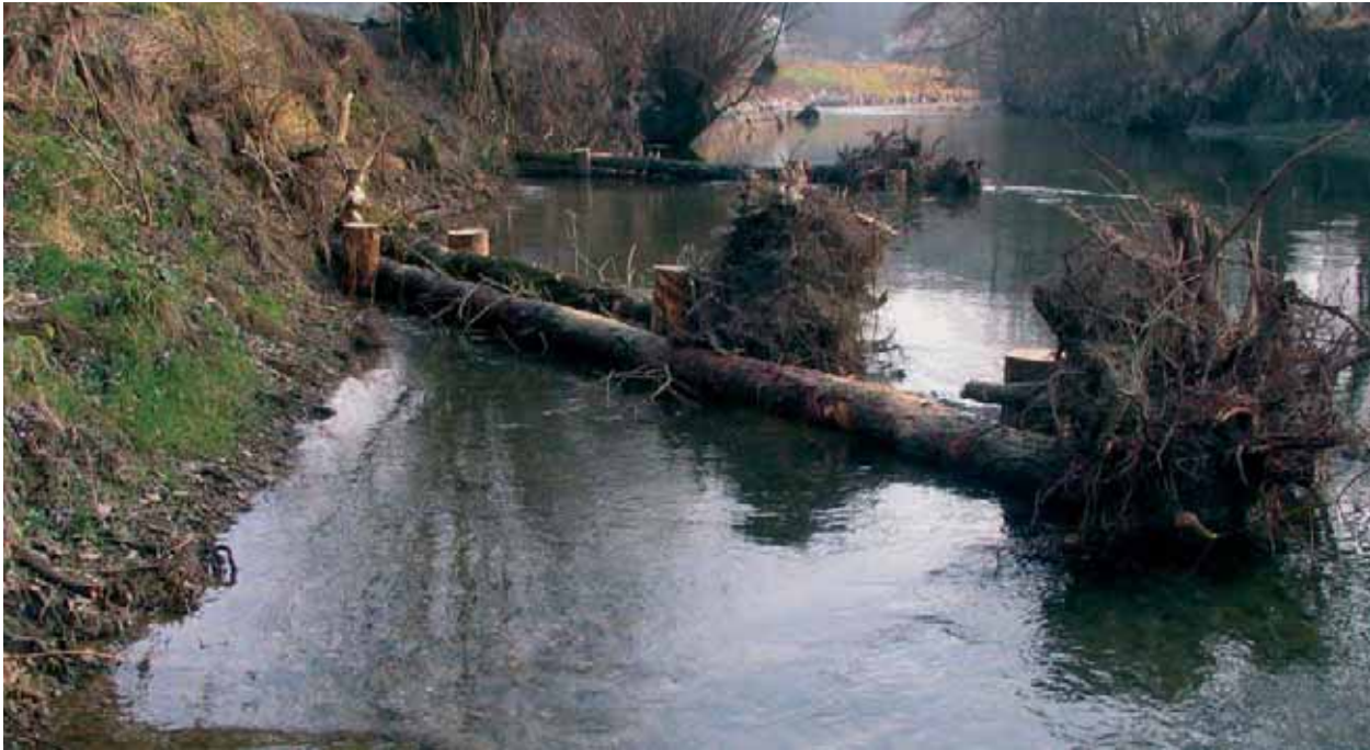
Abb. 73: Ingenieurbiologische Einbauten wie Raubbäume tragen zur Strukturvielfalt in monotonen Gewässerabschnitten bei (Quelle: BART)
