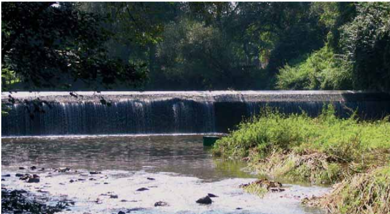
Abb. 74: Das Furthner-Wehr in der Probestrecke 1-10 sollte derart umgebaut werden, dass die Restwasserstrecke ständig und dem natürlichen Abflussregime entsprechend dotiert werden kann
