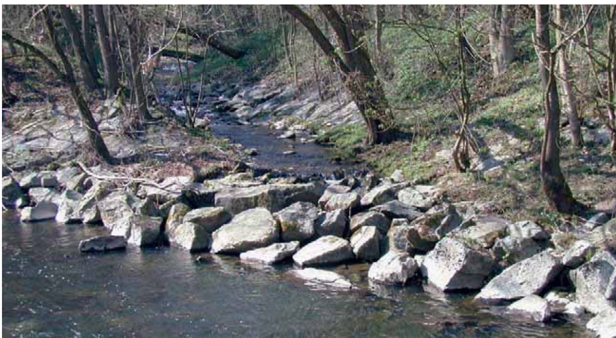
Abb. 78: Die Blockwurfsicherung der Antiesen unterbindet jegliche Migration in den Senftenbach
