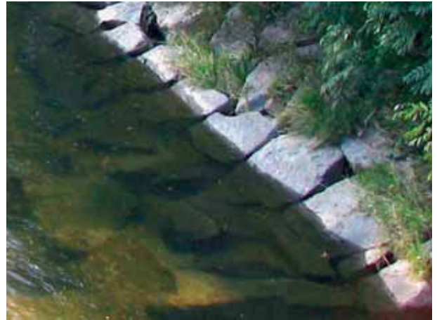
Abb. 26: Ufer- und Sohlverbauungen unterbinden die Wasser-Umland Vernetzung
