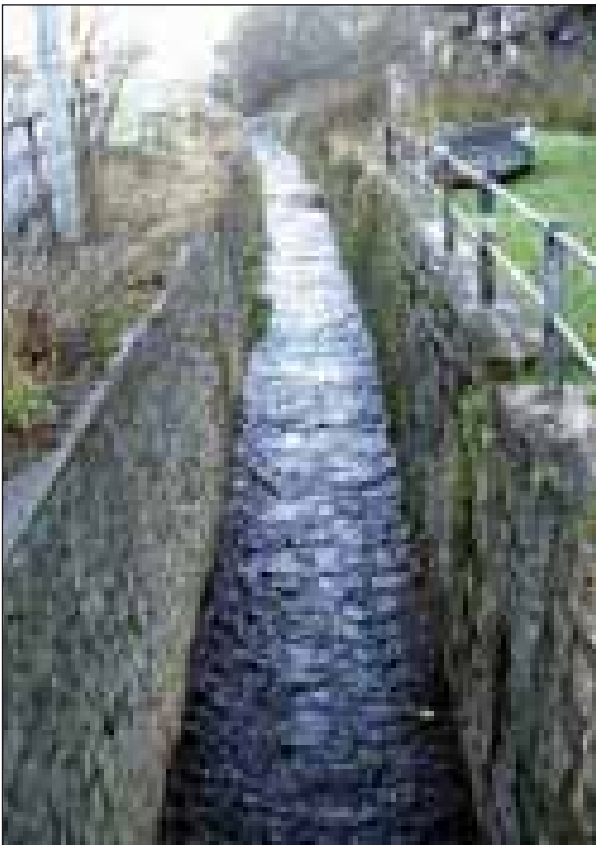
Abb. 83: Kanalierter Abschnitt im Schlager Bach
