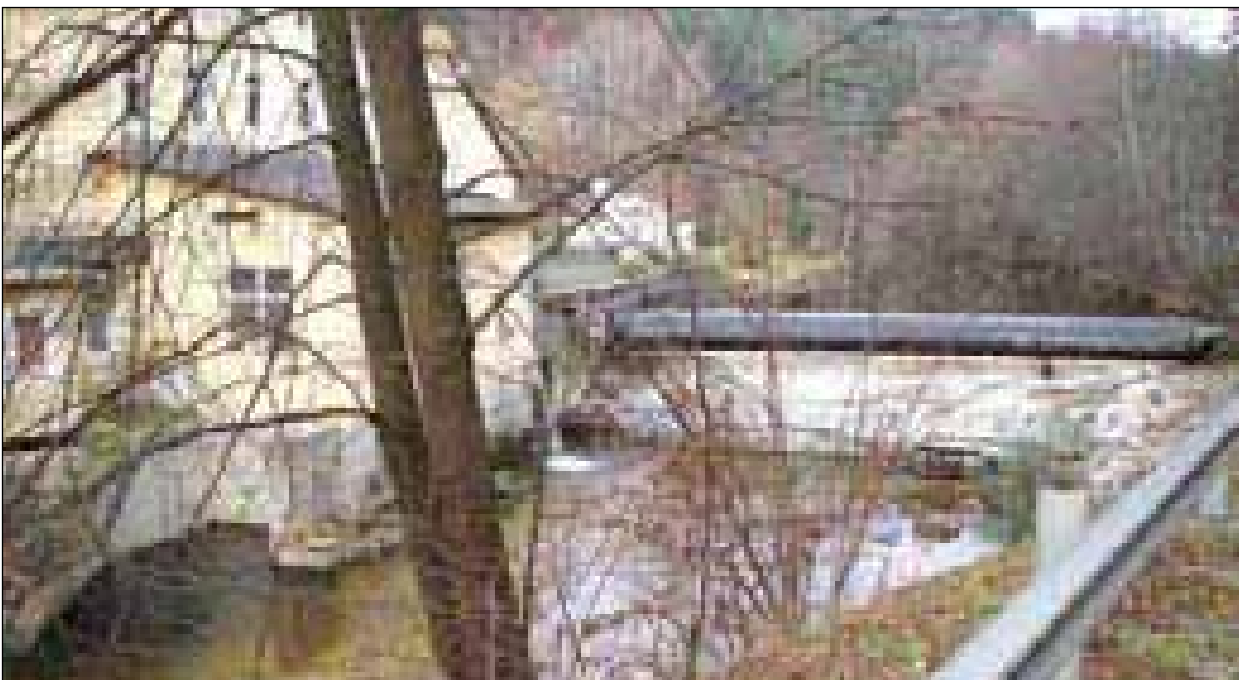
Abb. 1: Diese Wehranlage stellt ein unpassierbares Wanderhindernis für die aquatische Fauna dar
