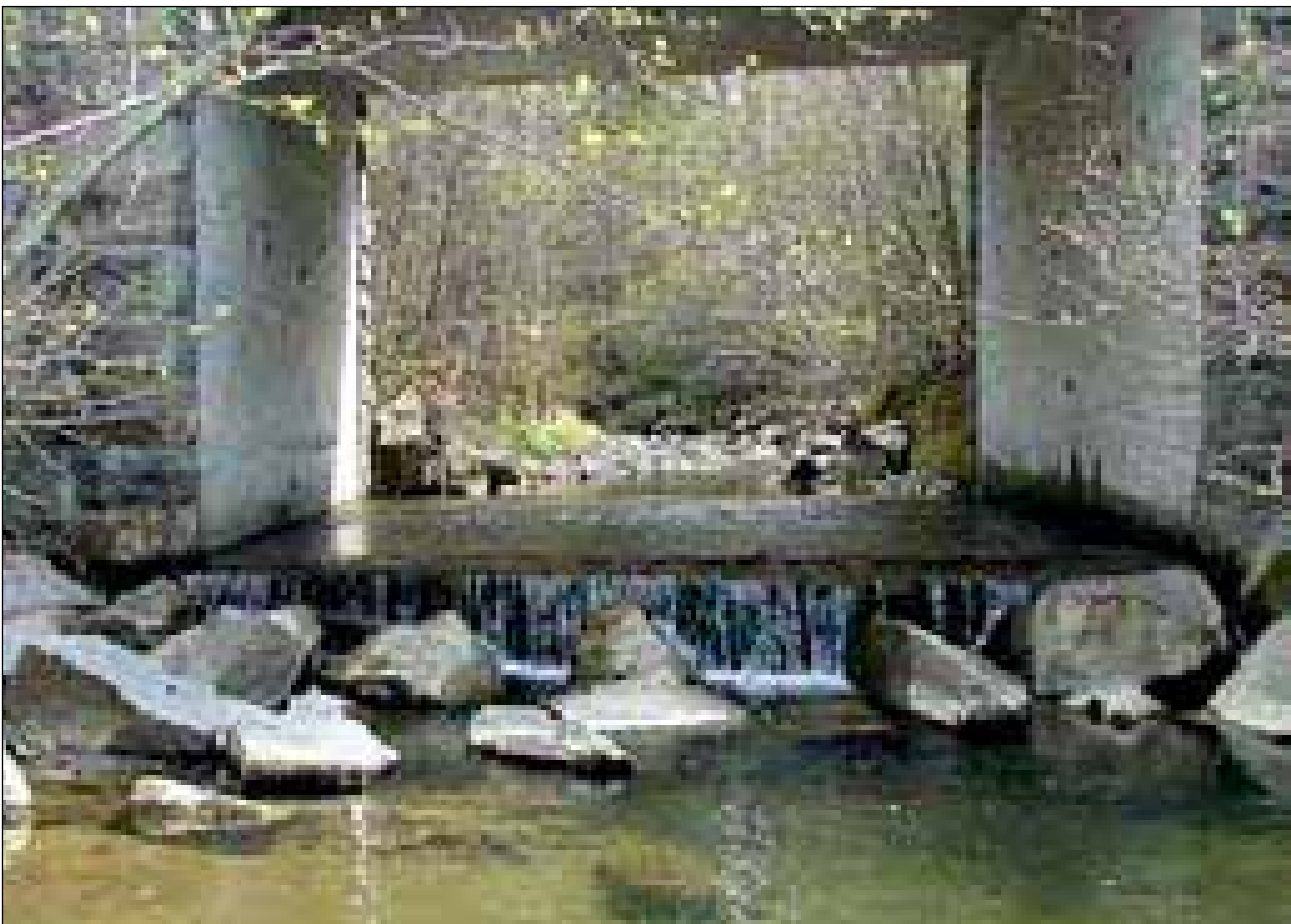
Abb. 11: Dieser Querbauwerksstandort verfügt über eine ganze Reihe konstruktiver Merkmale (siehe Text), die die Passierbarkeit verhindern (Foto: Nußbach)
