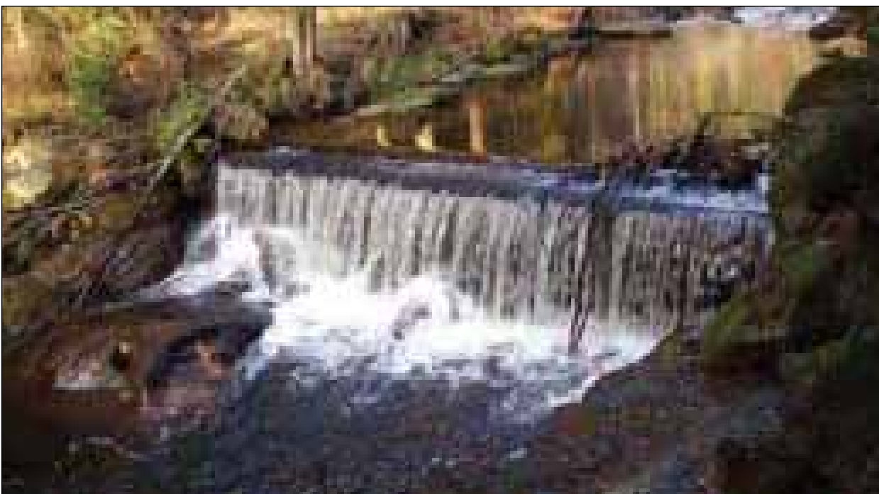
Abb. 8: Ein abgelöster Wasserstrahl ist für die aquatische Fauna nicht durchwanderbar (Foto: Schwarze Aist)
