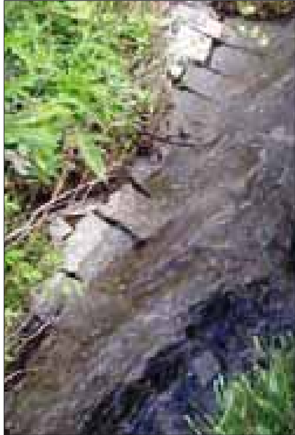
Abb. 160: Flussaufwärts der Mündung fließt der Etzenbach in einem sohlgeplasterten Bachbett
