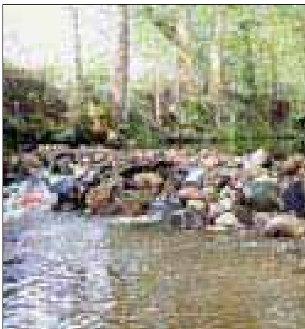
Abb. 9: Querbauwerke, die von einer Vielzahl kleiner Wasserkörper durchströmt sind, sind für Fische unpassierbar (Foto: Gusenbach)
