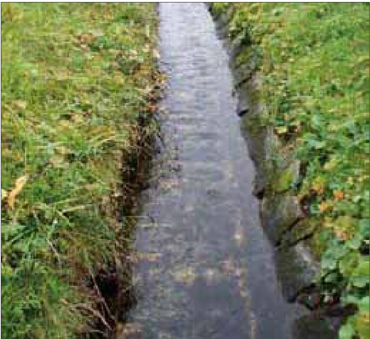
Abb. 2: Der Oberlauf der Weißen Aist wurde völlig degradiert und zu einem Abflusskanal umfunktioniert
