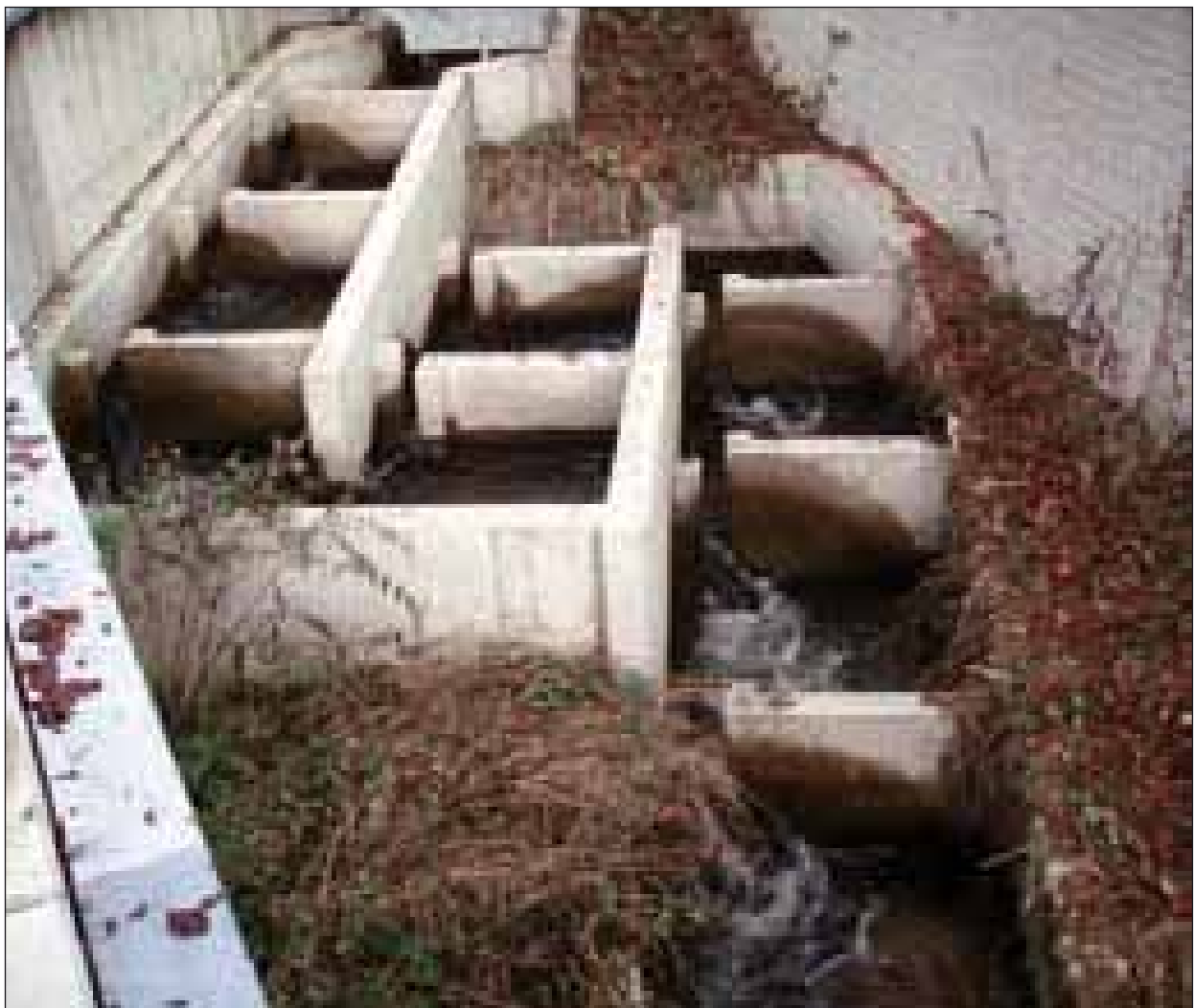
Abb. 168: Vertikalschlitzpass beim Kraftwerk Merckens II in der (Wald-)Aist
