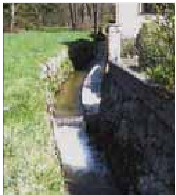
Abb. 29: Der Aisthofner Bach ist nur über wenige hundert Meter von wasserbaulichen Maßnahmen beeinflusst
