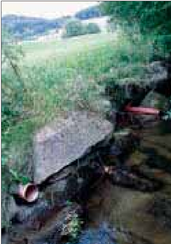
Abb. 71: Drainagerohre aus dem Golfplatz in St. Oswald bei Freistadt münden in den Heidbach
