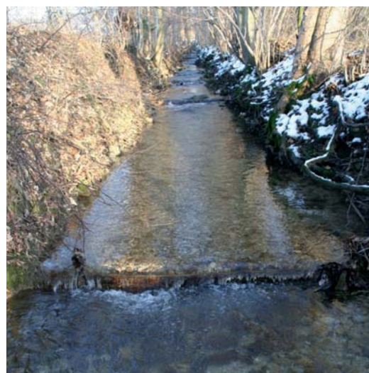
Abb. 122: Viele Querbauwerke ohne Nutzung verhindern die Einwanderung von aquatischen Organismen in den naturnahen Unterlauf des Zeller Baches.
