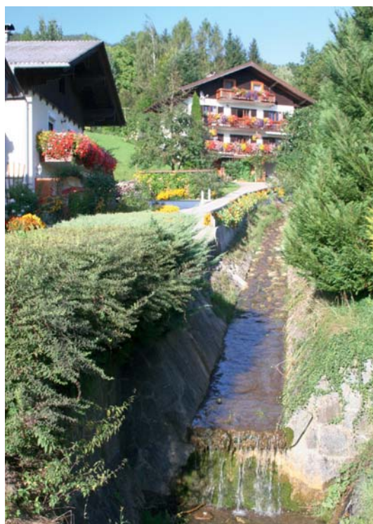
Abb. 99: Viele kleine Zuflüsse zum Mondsee weisen einen hohen Grad an Längsverbauung und Sohlbefestigung auf (Foto: Rehrnbach).
