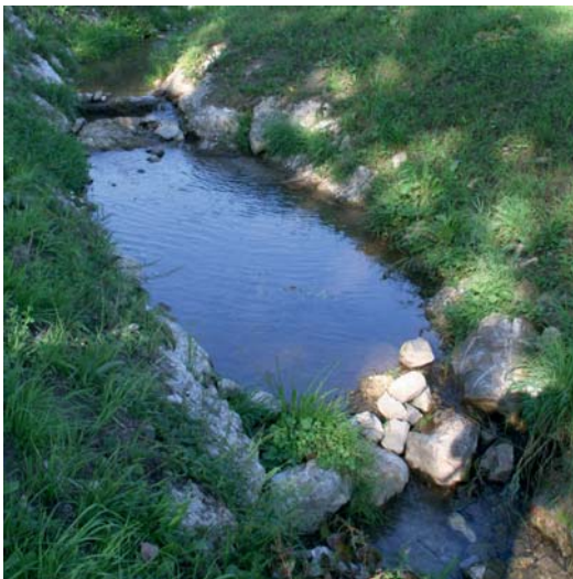
Abb. 132: Der Großteil der Querbauwerke in der restrukturierten Strecke des Kandlbaches wirkt als Wanderhindernis für einen großen Teil der aquatischen Fauna.
