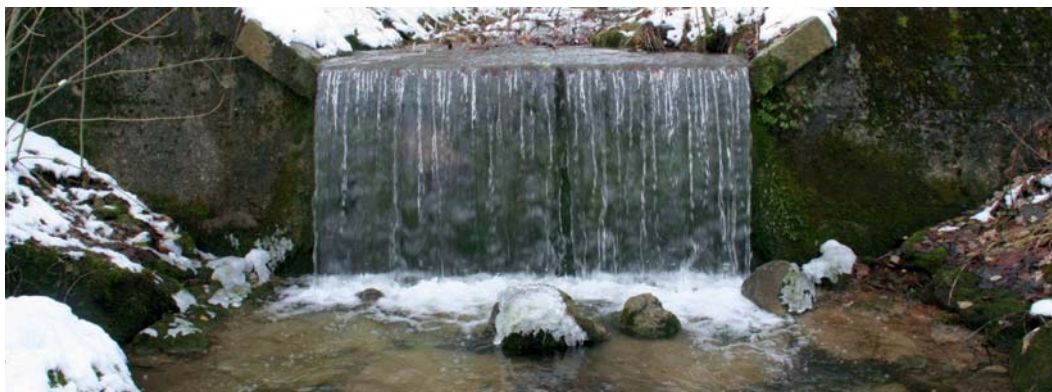
Abb. 22: Viele hohe Querbauwerke charakterisieren den regulierten Unterlauf des Hausstättergrabens.
