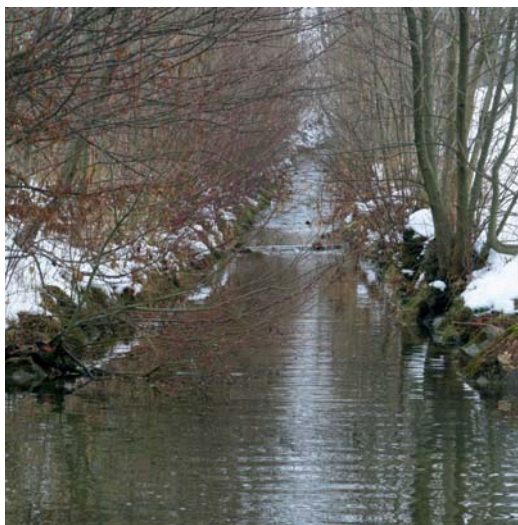
Abb. 115: Stark verbauter Unterlauf des Hausstättergrabens mit Querbauwerk (Wasserleitung) im Hintergrund.
