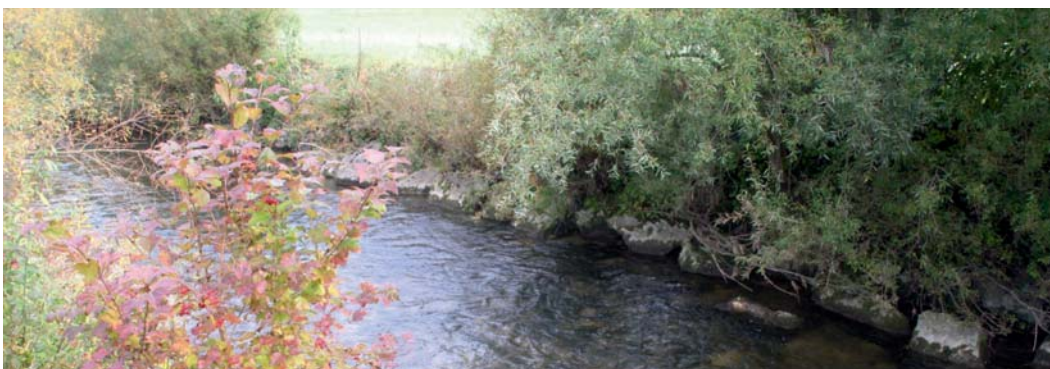
Abb. 107: Prallhangsicherung durch massive Blöcke in der Fuschler Ache.
