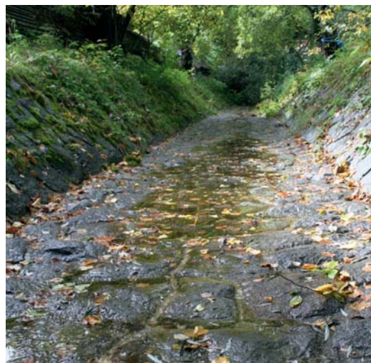
Abb. 139: Die gepflasterte Sohle des Klausbaches ist in ein Trapezprofil gefasst.
