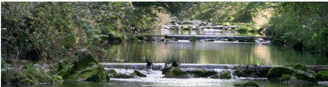
Abb. 59: Eine Kette von Querbauwerken verändert die hydromorphologische Situation im Unterlauf der Wangauer Ache stark.
