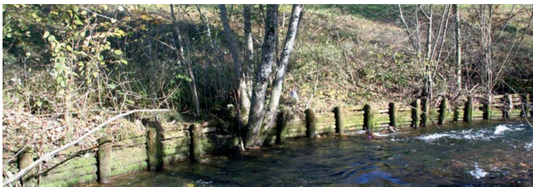
Abb. 93: Lokale Prallhangsicherung aus Holz in der Zeller Ache.
