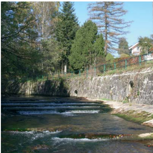
Abb. 125: Das Abschlussbauwerk des kanalisierten Bereichs der Zeller Ache an der Mündung des Steinerbaches.
