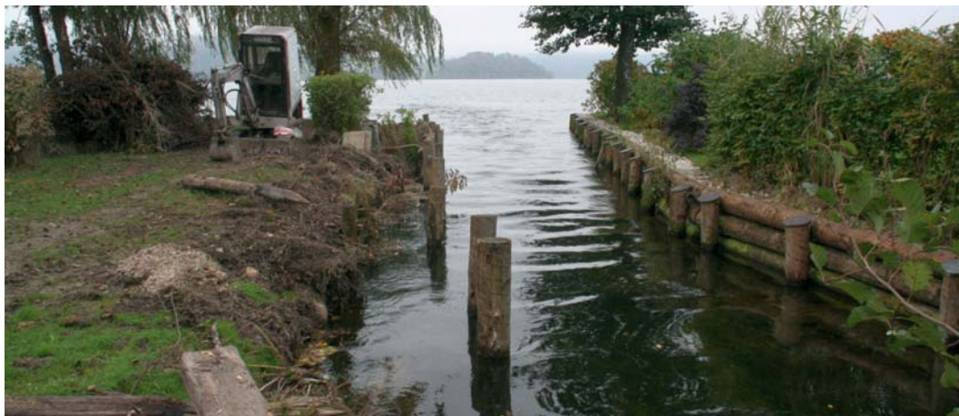
Abb. 72: Baustelle zur Ufersicherung im Mündungsbereich des Werkskanals in den Mondsee.
