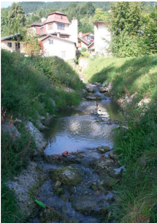
Abb. 98: Ufersicherung und Sohleinbauten durch Steine und Blöcke im Kandlbach kurz vor dem Oberende des restrukturierten Bereichs.
