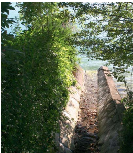
Abb. 11: Viele kleine Zuflüsse zu den Seen sind im Mündungsbereich als betonierte Rutsche ausgeführt (Foto: Schreitenbach).
