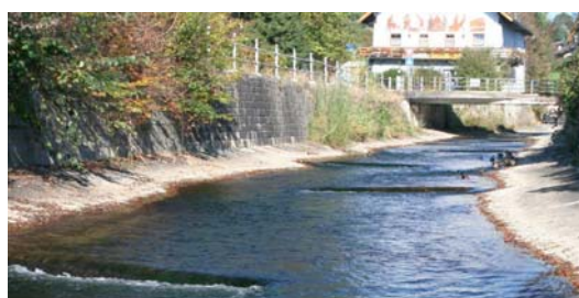
Abb. 12: Im kanalisierten Abschnitt der Zeller Ache in Mondsee wurden Holzbalken installiert.
