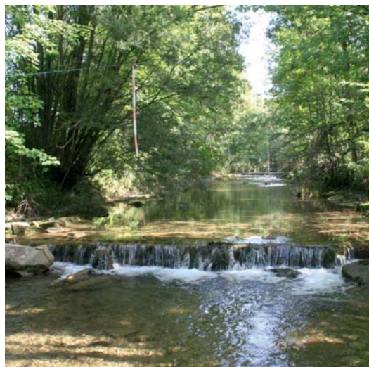
Abb. 135: Weitere Querbauwerke zerteilen die Wangauer Ache östlich der Bundesstraßenbrücke vor Loibichl.
