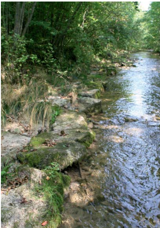
Abb. 100: Zusätzliche Ufersicherung am Prallhang im Unterlauf der Wangauer Ache.
