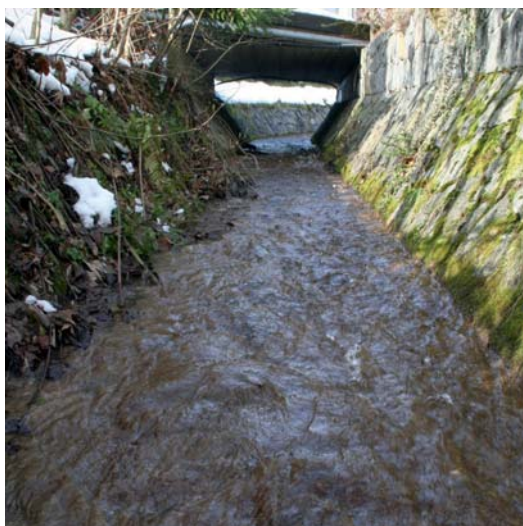
Abb. 117: Die Gewässersohl- und Uferverbauung des Schrankbaches bestehen im Bereich der Landesstraßenbrücke aus einer verfugten Pflasterung.
