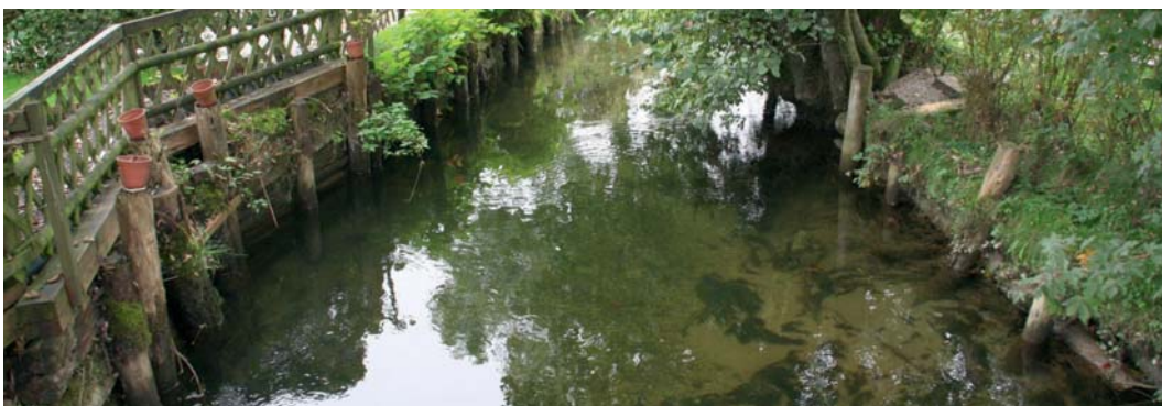
Abb. 109: Regelmäßig gewartete Ufersicherungen im Werkskanal im Bereich des ehemaligen Campingplatzes Stabauer.
