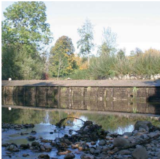
Abb. 141: An der Teufelmühle wird beinahe der gesamte Abfluss der Fuschler Ache ausgeleitet.
