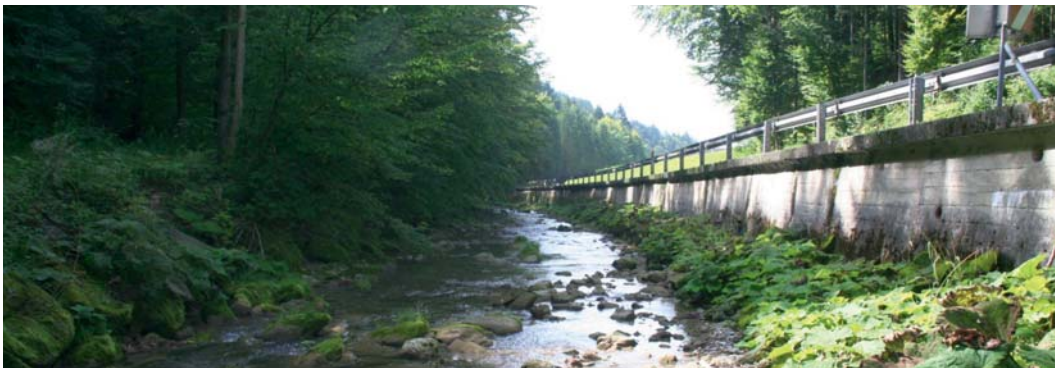
Abb. 101: Die Straßensicherung hat nur lokal stabilisierende Wirkung auf die Wangauer Ache.
