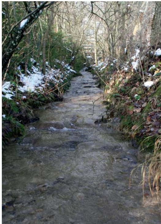
Abb. 87: Die Gewässersohle des Schrankbaches ist ab der Mündung durchgehend mit Steinen und Blöcken gepflastert. Die Ufer sind als Trapezprofil ausgeführt und ebenfalls durchgehend gesichert.
