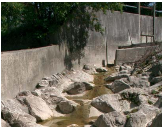
Abb. 20: Beckenpass in der Wangauer Ache bei der Wasserkraftanlage in Loibichl.
