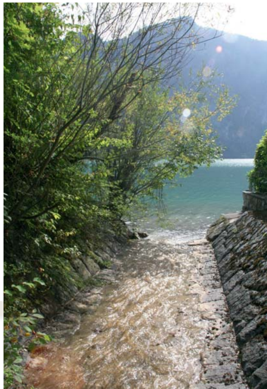
Abb. 63: Die Mündungssituation des Ortlergrabens lässt keine Nutzung durch aquatische Organismen aus dem See zu.
