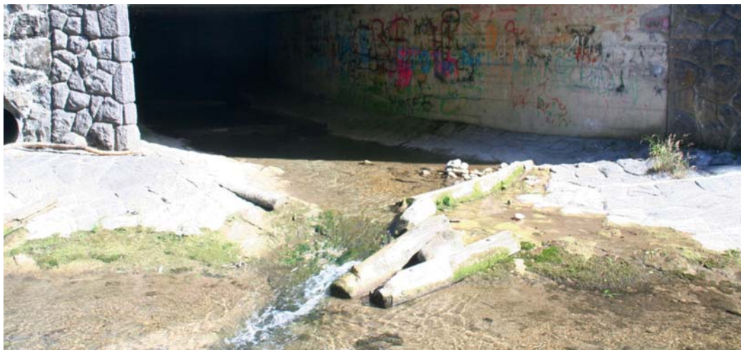
Abb. 13: Heutige Mündung des unterirdisch geführten Steinerbaches in den kanalisierten Bereich der Zeller Ache.
