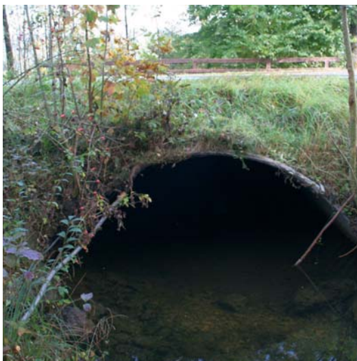
Abb. 138: Die Bundesstraßenunterquerung des Egelbaches stellt kein Wanderhindernis für aquatische Organismen dar.
