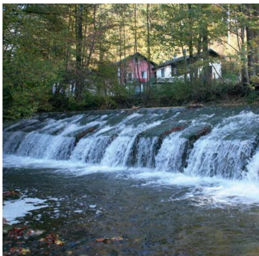
Abb. 128: Das zweite, der insgesamt vier unüberwindbaren Querbauwerke ohne Nutzung in der Zeller Ache bis zum Beginn des Helenentals.
