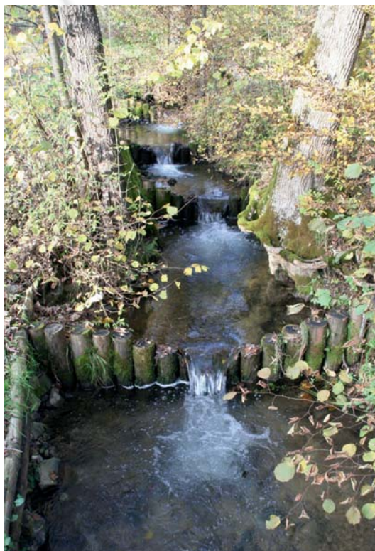
Abb. 18: Beckenpass in der Zeller Ache an der Haidermühle.
