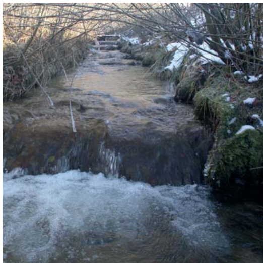
Abb. 120: Die Lebensraumfunktion des Pangrabens ist durch Ufer- und Sohlverbauung und zahlreiche Querbauwerke stark beeinträchtigt.
