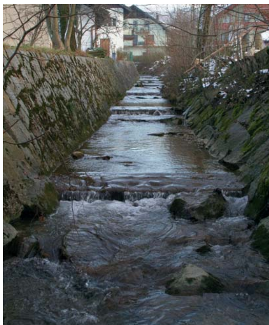
Abb. 35: Im Ortsgebiet von Zell am Moos ist der Zeller Bach durch einen hohen Verbauungsgrad charakterisiert.
