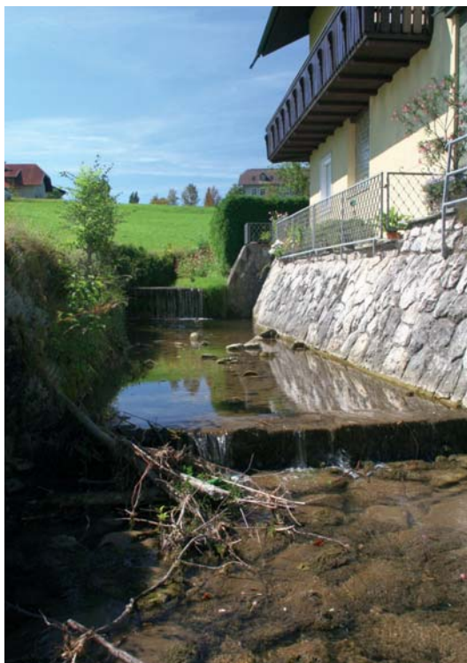
Abb. 97: Sowohl Sohle als auch Ufer des Steinerbaches weisen einen sehr hohen Verbauungsgrad auf.
