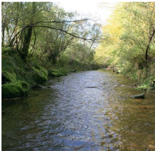
Abb. 140: Die Ufer der Fuschler Ache sind größtenteils durch Blöcke gesichert und überhöht, das Bett ist zusätzlich eingetieft.
