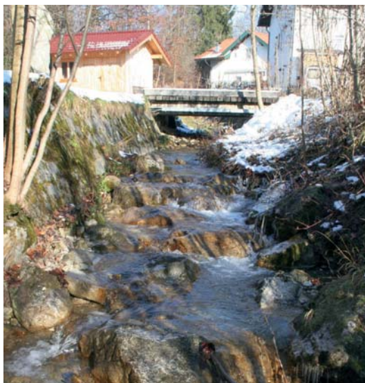
Abb. 90: Sowohl Ufer als auch Sohle des Pangrabens wurden massiv gesichert.
