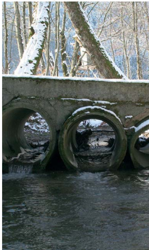
Abb. 6: Querbauwerke, ohne Sohlbindung, sind für Makrozoobenthosorganismen unpassierbar (Foto: Ritzinger Bach).
