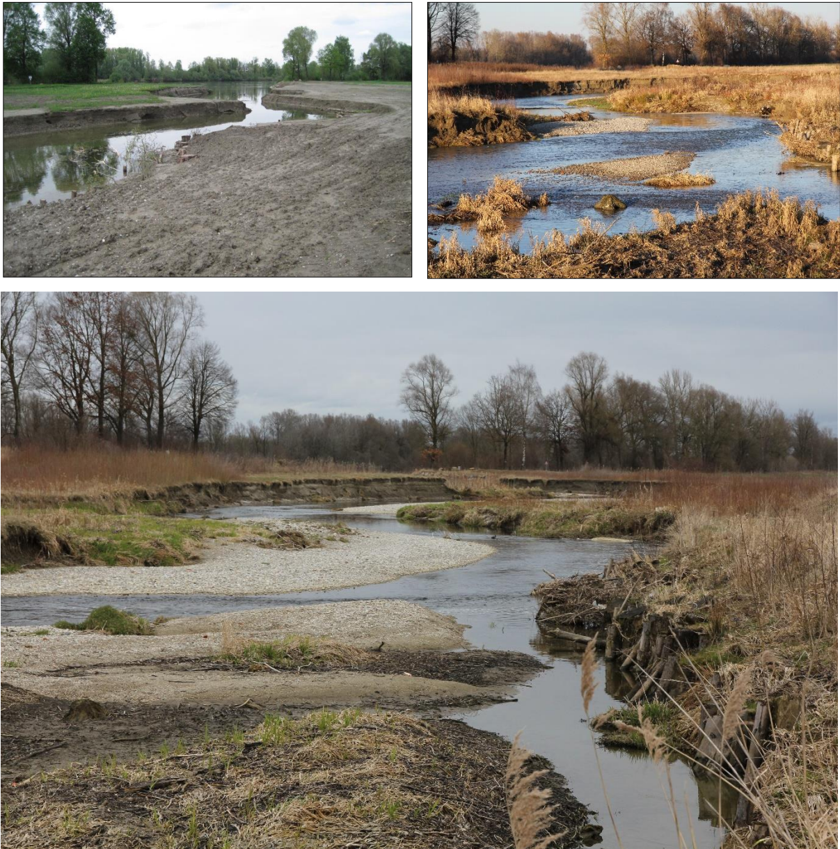
Abb. 47 Entwicklung der Gurtenbach-Mündungsstrecke von 2010 (Abschluss der Bauarbeiten, links oben) über 2012 (rechts oben) bis 2013 (unten) (Quelle: Gregor Riegler, Gewässerbezirk Braunau).
