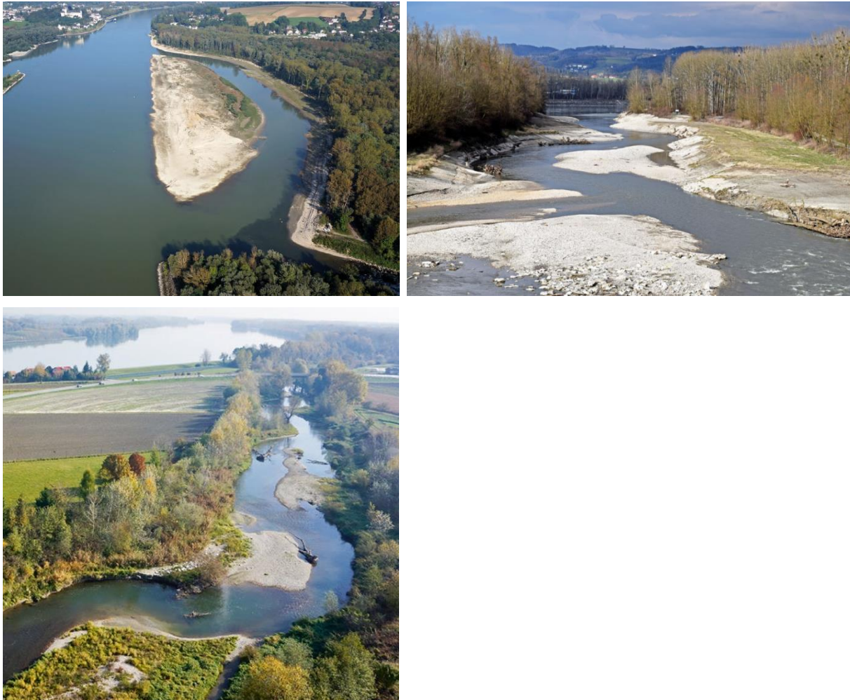
Abb. 38 Neu geschaffene Insel und Nebenarm in der Donau bei Markttau auf Höhe der Innbach-Mündung (oben links) und reich strukturierter Einstiegsbereich in das Umgehungsgerinne für das KW Ottensheim-Wilhering (oben rechts) (Quelle: ZAUNER et al. 2016); natürlicher, strukturreicher Abschnitt des Umgehungsgerinnes mit Nebenarmcharakter (unten) (Quelle: ZAUNER et al. 2017).
