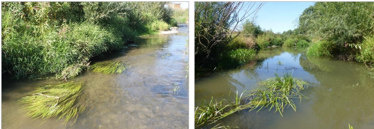
Abb. 26 Leitbildkonform renaturierter Abschnitt im Leitenbach-Unterlauf (links) und Abschnitt mit zu geringem Gefälle im Oberwasser eines baulichen Zwangspunkts (rechts).
