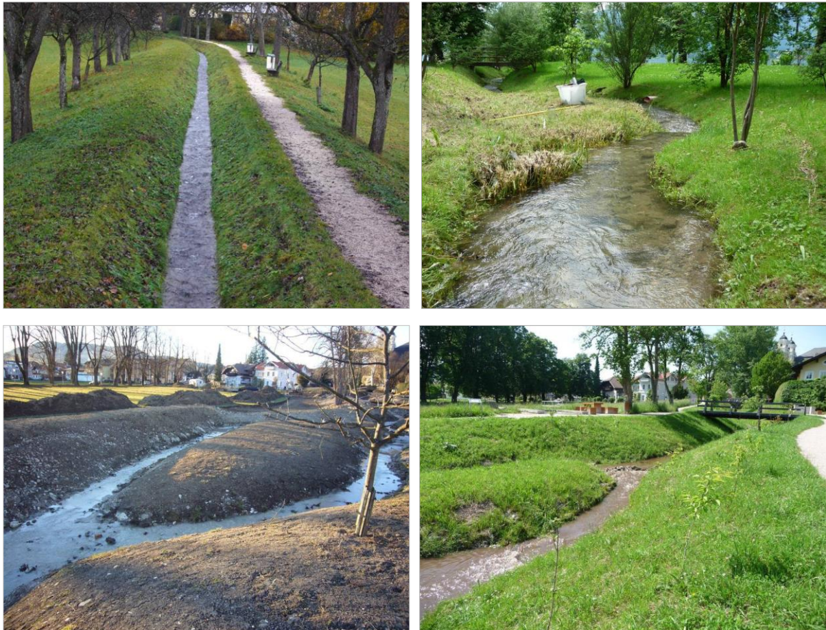
Abb. 49 Zustand des gesamten Kandlbach-Unterlaufs vor der ökologischen Aufwertung (links oben), im Jahr 2000 bereits aufgewerteter Mündungsabschnitt (oben rechts), Unterlauf im Ortsgebiet von Mondsee unmittelbar nach Abschluss der Rückbauarbeiten (unten links) und derselbe Abschnitt zwei Jahre danach (unten rechts) (Quelle: SCHEDER et al. 2010).
