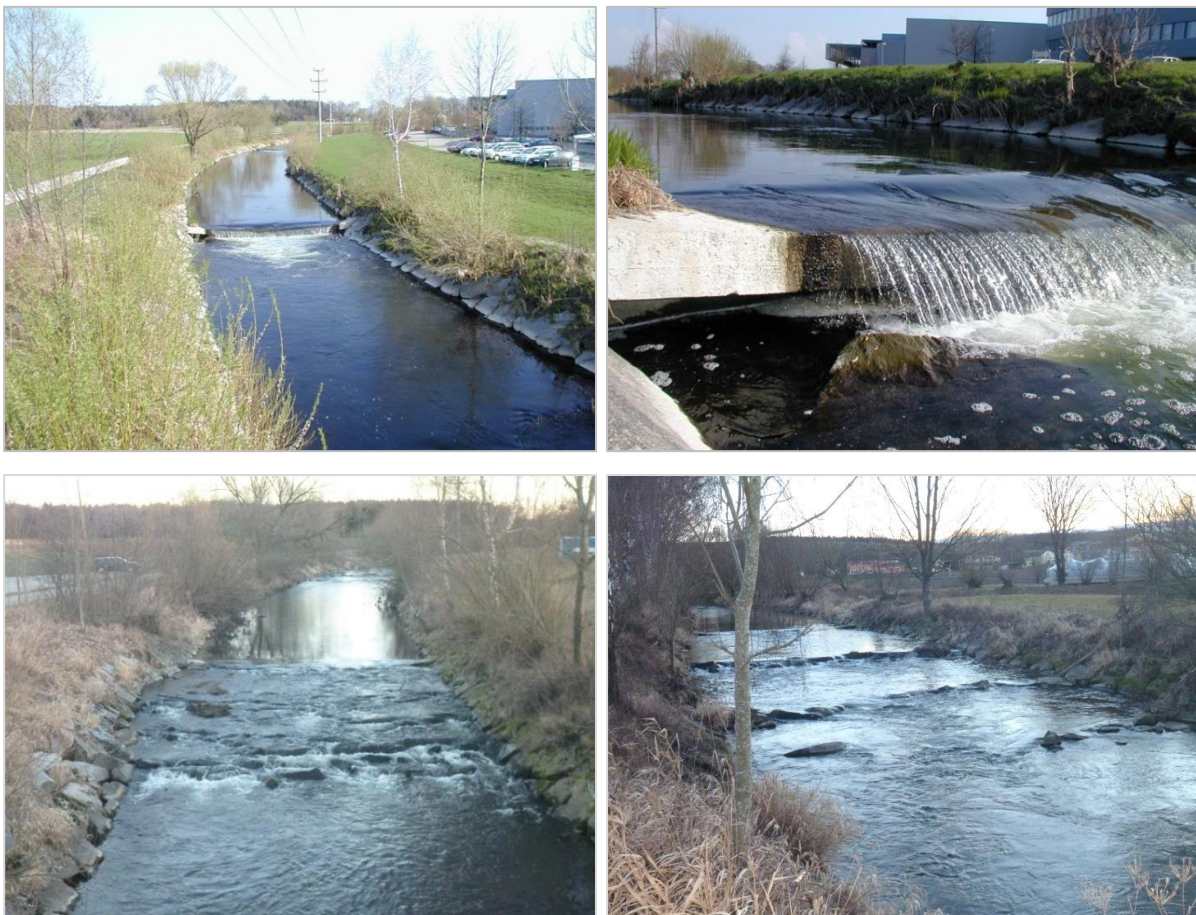
Abb. 51 Querbauwerke in der Antiesen vor (oben) und nach dem Umbau (unten) (Quelle: BERG et al. 2014).
