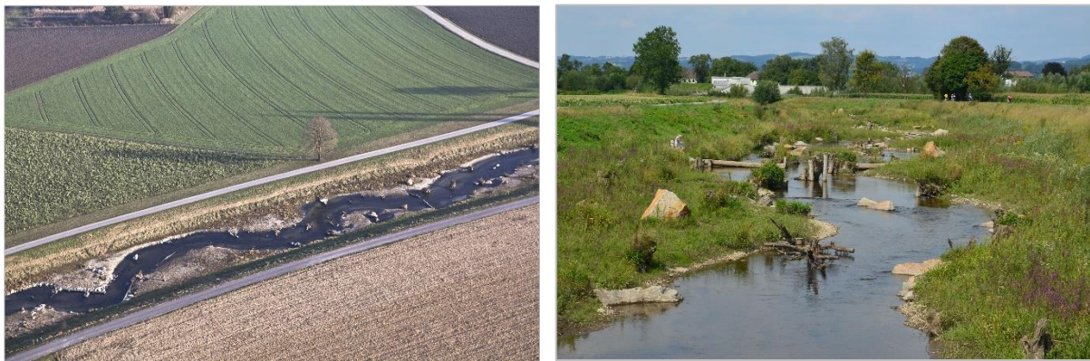
Abb. 35 Ökologisch aufgewerteter Mündungsabschnitt der Naarn in der Kaindlau unmittelbar nach Fertigstellung (links) (Quelle: Fotostudio Weißenbrunner) und nach Etablierung der Uferbegrünung (rechts) (Quelle: Gewässerbezirk Linz).
