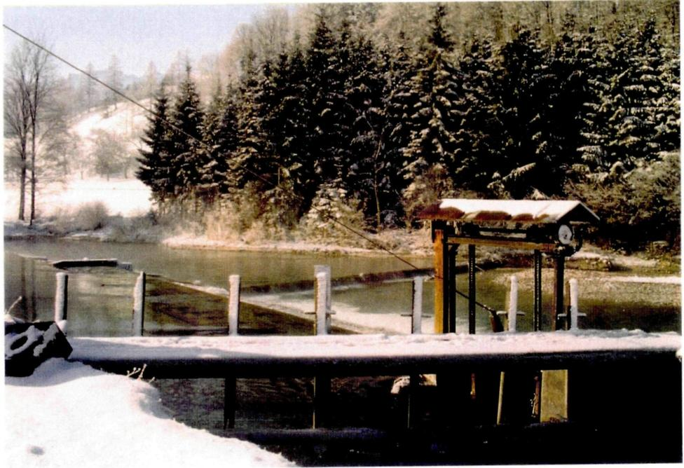
Abb. 50: Die Ausleitungsstelle des Mühlbaches am Sagbauernwehr
