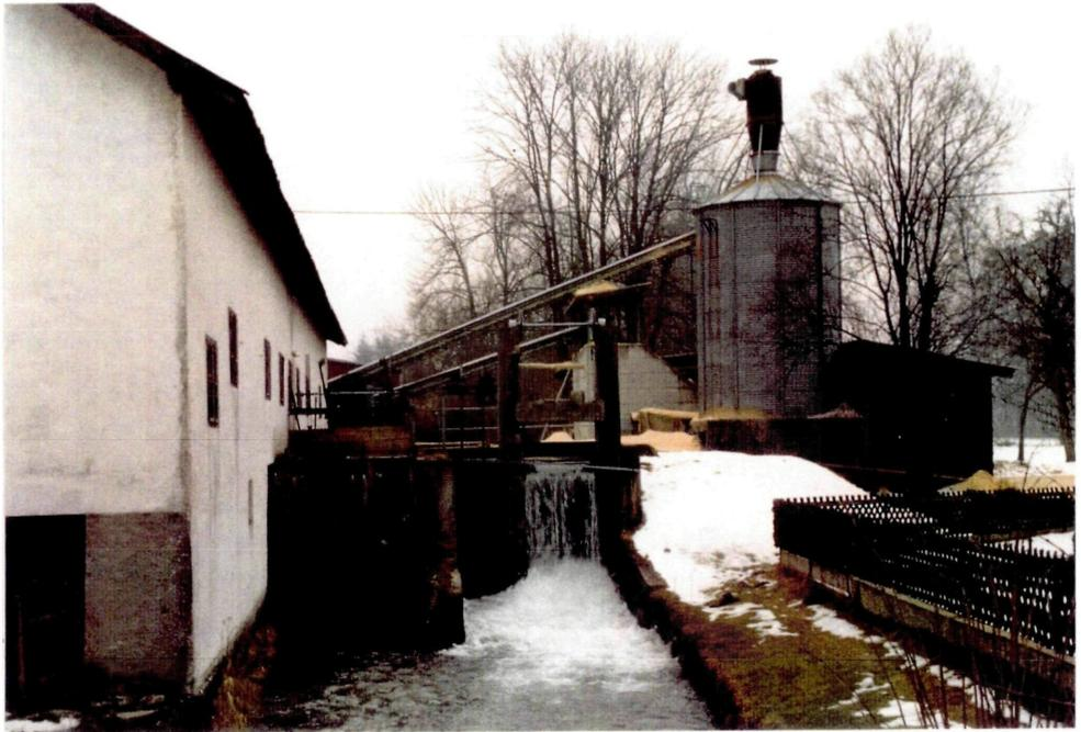
Abb. 112: Überschußgerinne und Auslaufbauwerk der Sattelmühle
