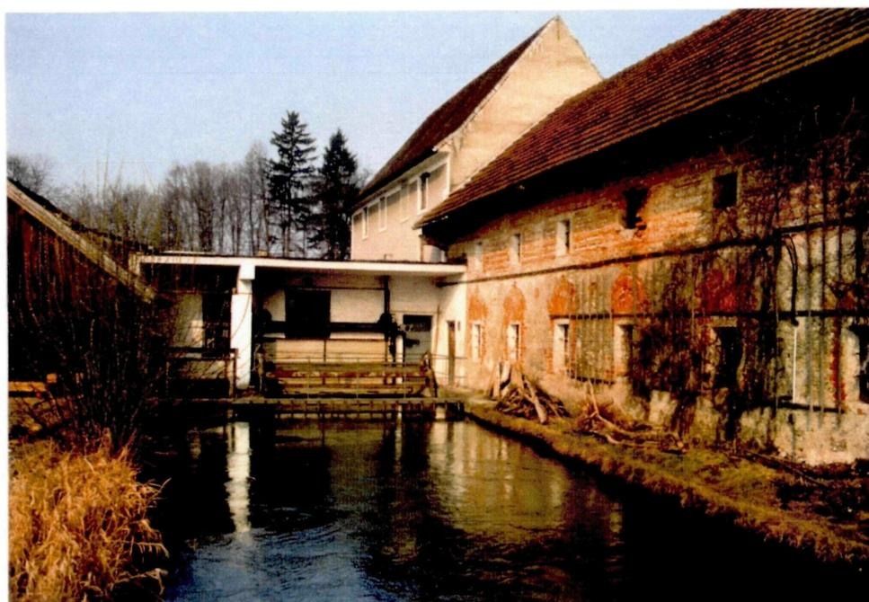
Abb. 134: Rechen- und Einlaufbauwerk der Kranabethmühle
