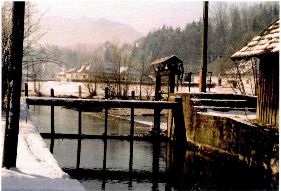
Abb. 52: Ausleitungsstelle des Mühlbaches der Niedersäge
