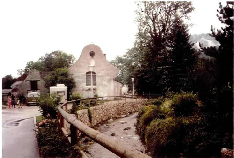
Abb. 68: Die Krems verläuft in diesem Abschnitt in einem aus Kalkstein aufgemauerten Bett
