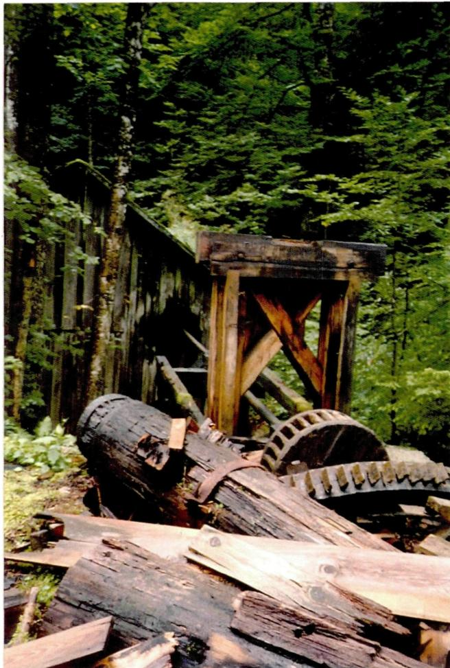
Abb. 58: Das durch eine Explosion des Pulvermischwerkes zerstörte Turbinenhaus
