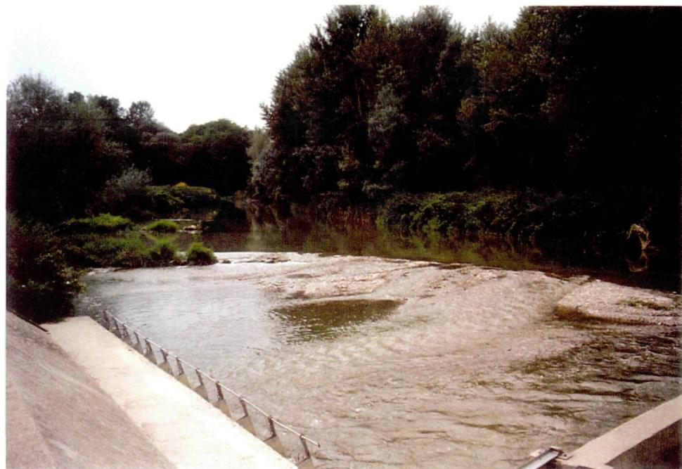
Abb. 51: Die gesamte Wassermenge der Krems wird am Lellwehr in den Freindorfer Mühlbach eingezogen.
