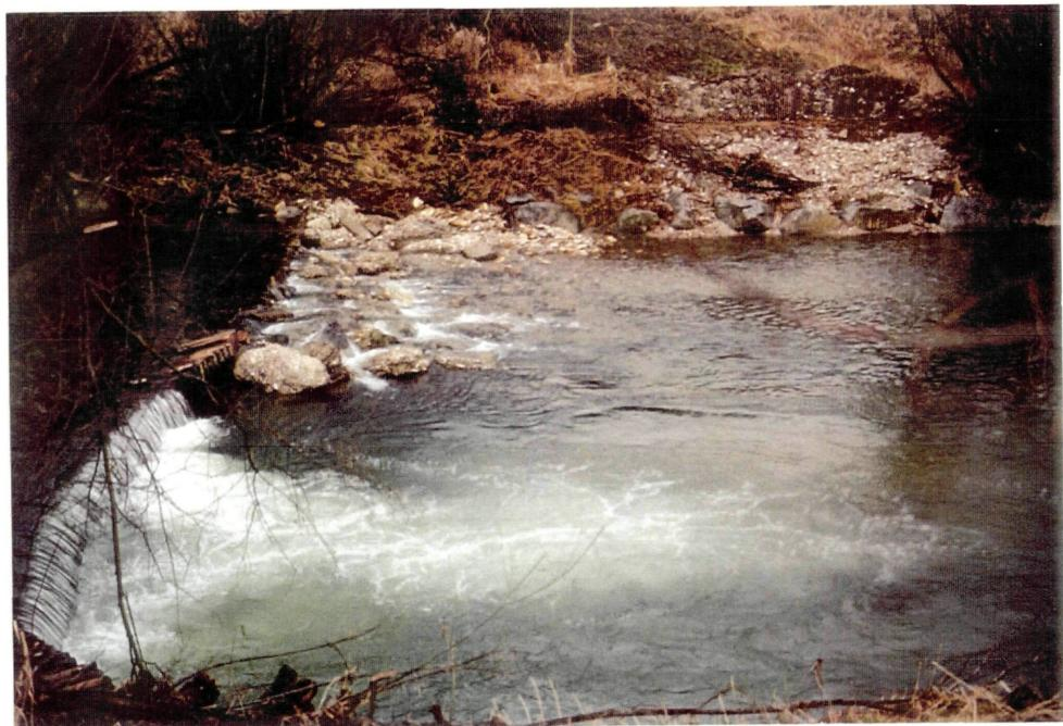
Abb. 83: Einbau von Buhnen an einer Sohlschwelle in der
