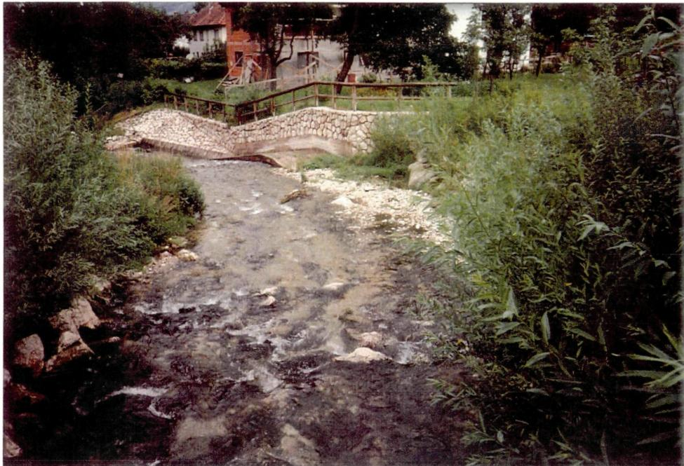
Abb. 71: An der früheren Einleitungsstelle des Mühlbaches befindet sich heute eine Rampe aus Kalkbruchsteinen, die Uferböschungen sind aufgemauert
