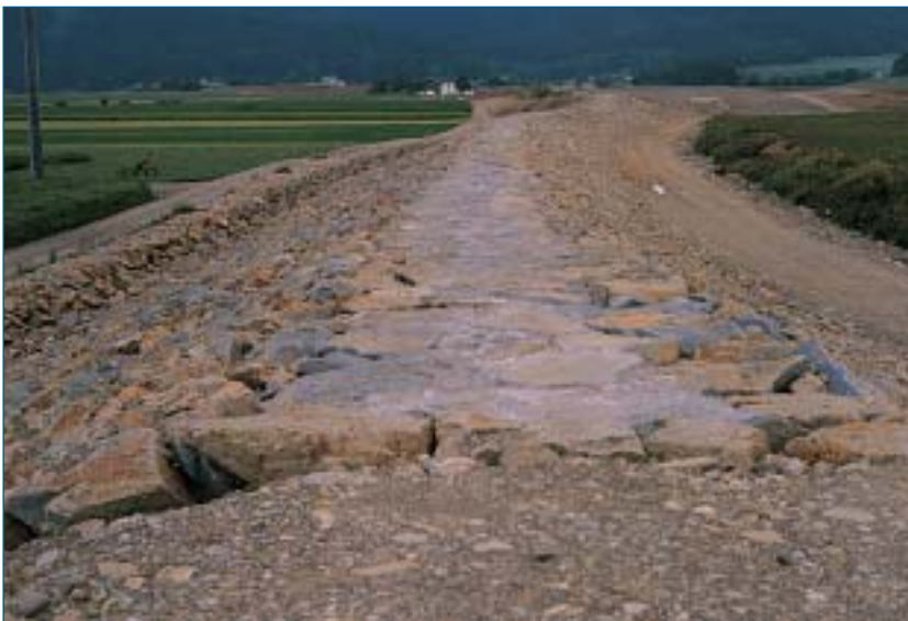
Abb. 25: Überlaufstrecke Becken West vor der Humusierung, Foto: GEWÄSSERZIRK BRAUNAU.
