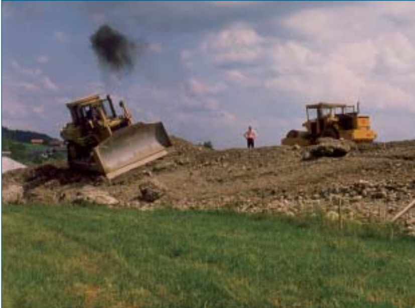
Abb. 13: Beginn der Bauarbeiten, Foto: GEWÄSSERBEZIRK BRAUNAU.
