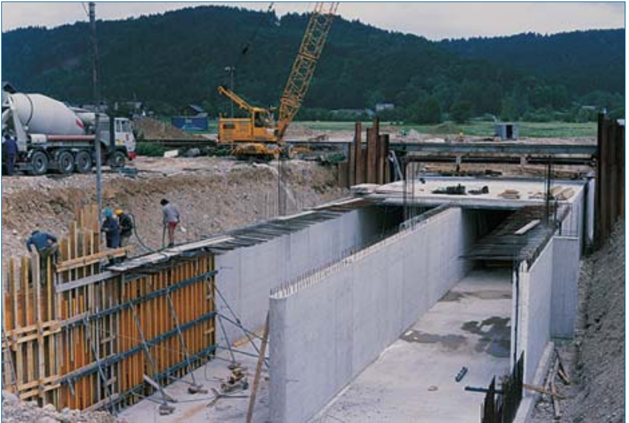
Abb. 28: Die Errichtung des Verbindungsbauwerkes zwischen den Becken Ost und West in Teichstätt, Foto: GEWÄSSERBEZIRK BRAUNAU.
