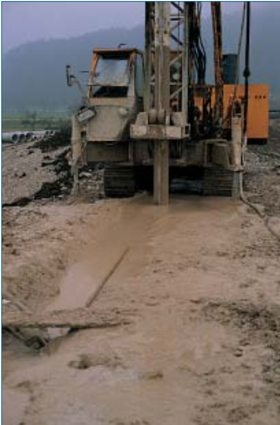
Abb. 19: Die Errichtung der Schmalwand beim Becken Ost, Foto: GEWÄSSERZIRK BRAUNAU.
