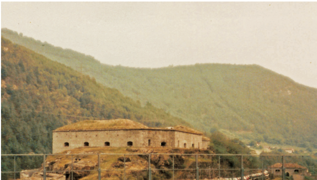
Abb. 2: Detail der Franzensfeste, erbaut zwischen 1833 bis 1838 unter Kaiser Ferdinand I. (1793-1875) und nach Kaiser Franz I. von Österreich (1768-1835), dem Monarchen während der Planungsphase, benannt.
