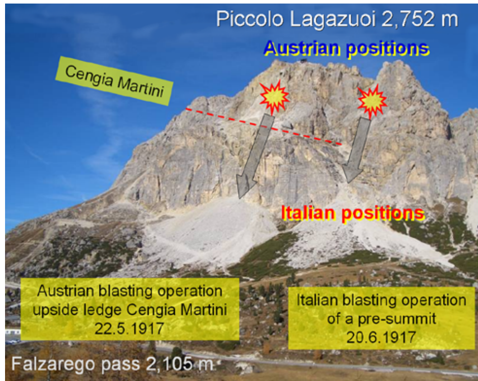
Abb. 8: Südwand und Wandfuß des Kleinen Lagazuoi (Blick vom Falzarego Pass nach Nord-west). Die beiden durch Minenexplosionen verursachten Schuttkegel beinhalten 200.000 m 3 (Schramm 2011a). Etwa in mittlerer Wandhöhe befindet sich ein ostwärts absinkendes Felsband, die von einem italienischen Vorposten besetzte „Cengia Martini“. Foto: Schramm.
