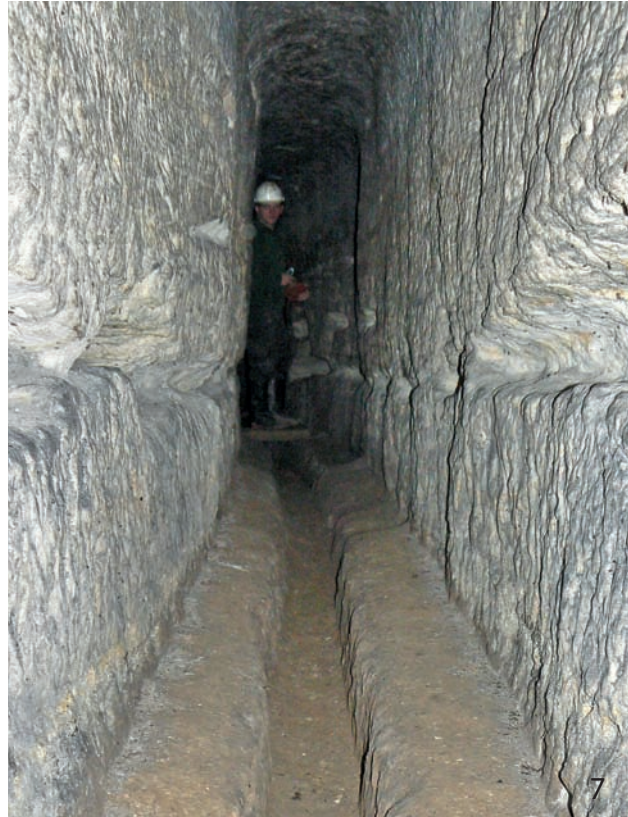
Abb. 6: Stollenquerschnitt bei etwa 60 m vom Mundloch, am rechten Stoß ist der Sandnesterhorizont aufgeschlossen (Blickrichtung Mundloch, Firstenhöhe ca. 2,4 m, Sohlenbreite ca. 0,6 m, Firstenbreite ca. 0,4 m).
