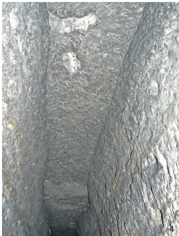
Abb. 4: Spuren der Schlegel- und Eisen-Arbeit im ersten Drittel des Stollens (Blick auf die Firste in Richtung Mundloch, Firstenbreite ca. 0,5 m).
