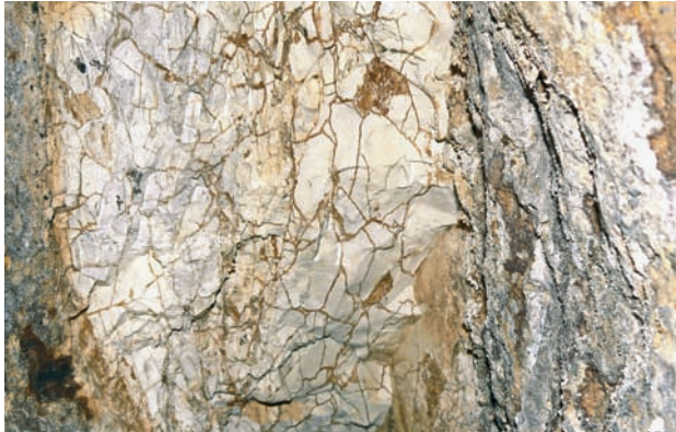
Abb. 15: Anschnitt des „Specksteinganges“ in der NE-Strecke mit einer Mächtigkeit von ca. 0,2 m.
