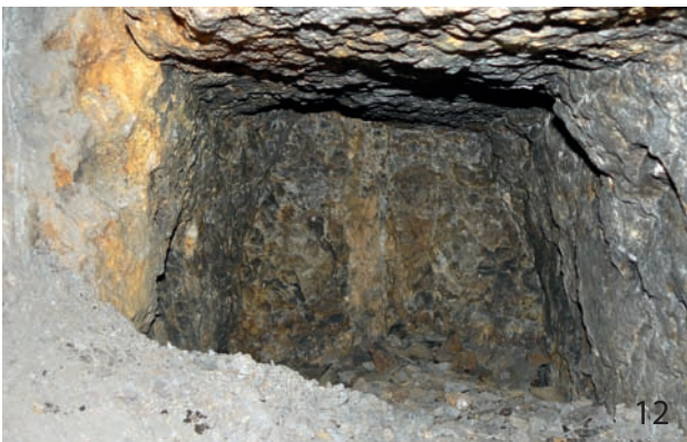
Abb. 10: Plastischer, ockerfarbener „Basaltzersatz“ am Südweststoß, der einen nach Südwest aufgefahrenen Hohlraum vollständig ausfüllt (ca. 83 m vom Mundloch).
