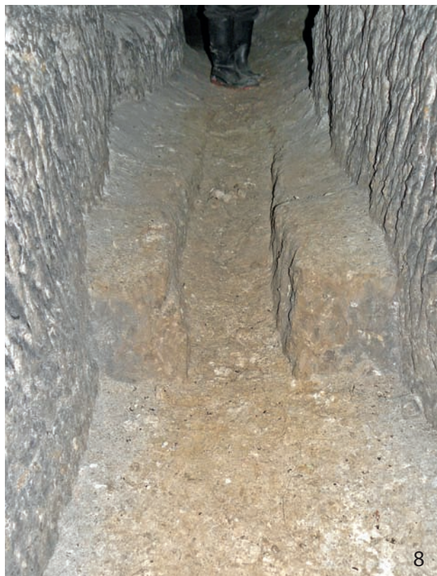
Abb. 8: Ende der auf der Sohle ausgehauenen Wassersaige bei ca. 50 m vom Mundloch.
