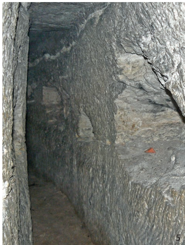
Abb. 4: Spuren der Schlegel- und Eisen-Arbeit im ersten Drittel des Stollens (Blick auf die Firste in Richtung Mundloch, Firstenbreite ca. 0,5 m).
