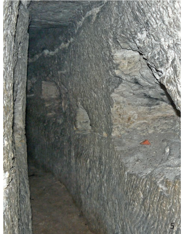
Abb. 4: Spuren der Schlegel- und Eisen-Arbeit im ersten Drittel des Stollens (Blick auf die Firste in Richtung Mundloch, Firstenbreite ca. 0,5 m).
