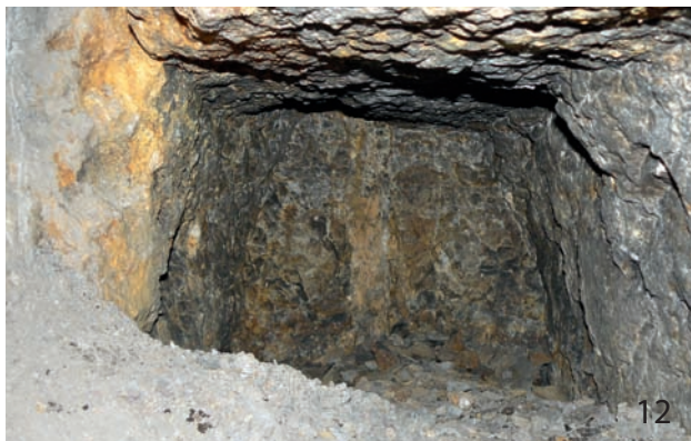
Abb. 10: Plastischer, ockerfarbener „Basaltzeratz“ am Südweststoß, der einen nach Südwest aufgefahrenen Hohlraum vollständig ausfüllt (ca. 83 m vom Mundloch).
