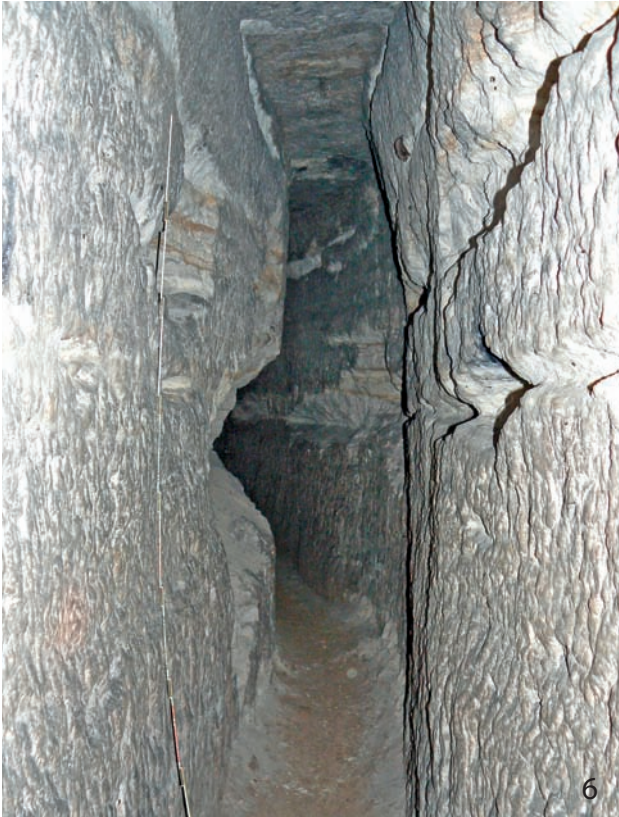
Abb. 6: Stollenquerschnitt bei etwa 60 m vom Mundloch, am rechten Stoß ist der Sandnesterhorizont aufgeschlossen (Blickrichtung Mundloch, Firstenhöhe ca. 2,4 m, Sohlenbreite ca. 0,6 m, Firstenbreite ca. 0,4 m).
