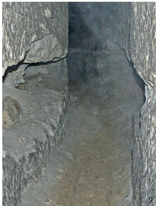
Abb. 9: Unregelmäßige Aushöhlungen an beiden Stößen bei ca. 46 m mit ca. 1 m Tiefe und 0,5 m Höhe (Blick in Richtung Mundloch).
